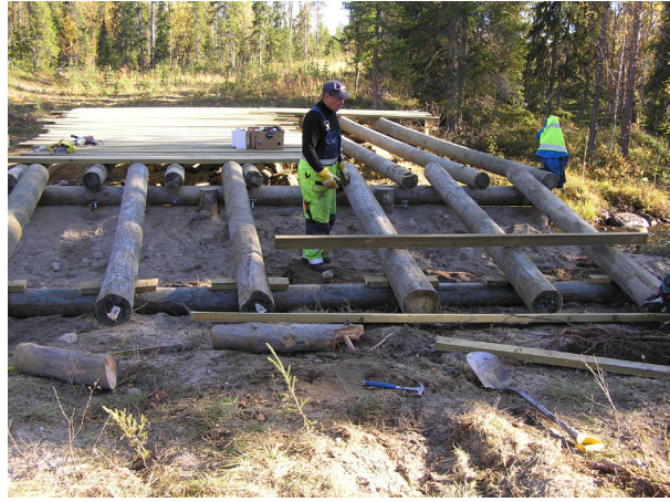
Kuva 9. Kelkkareittisillan tekoa Kemijärven Portinjoen yli. Pekka Takalo.
