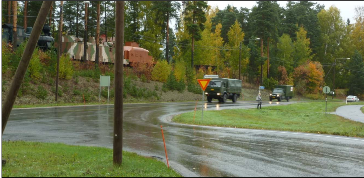
Kuva 19. Kevyen liikenteen väylän rakentaminen parantaa kevyen liikenteen turvallisuutta.
