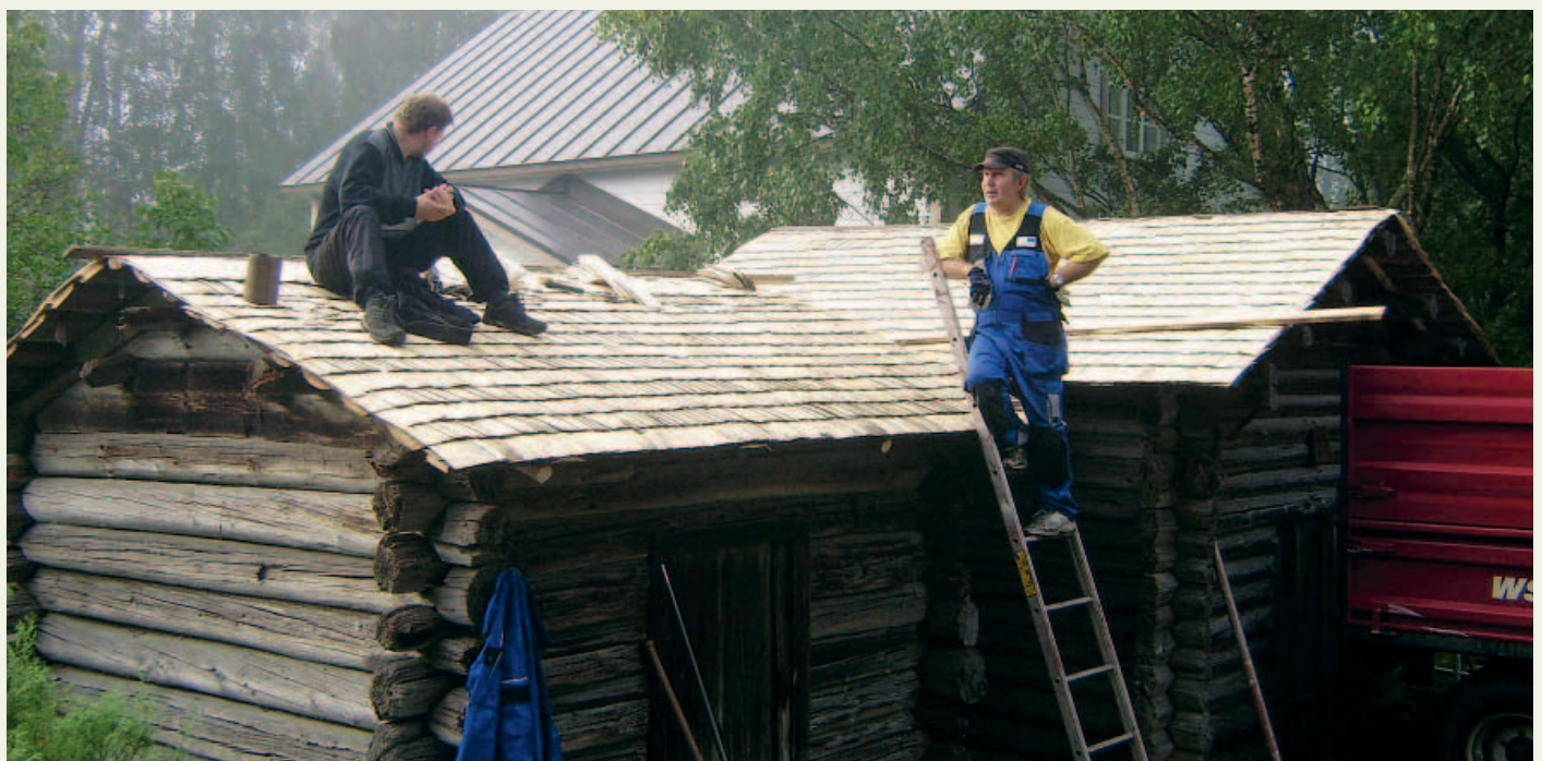
Rautalammin museoalueella uusittiin kahden aitan ja vanhan tuvan pärekatot.
