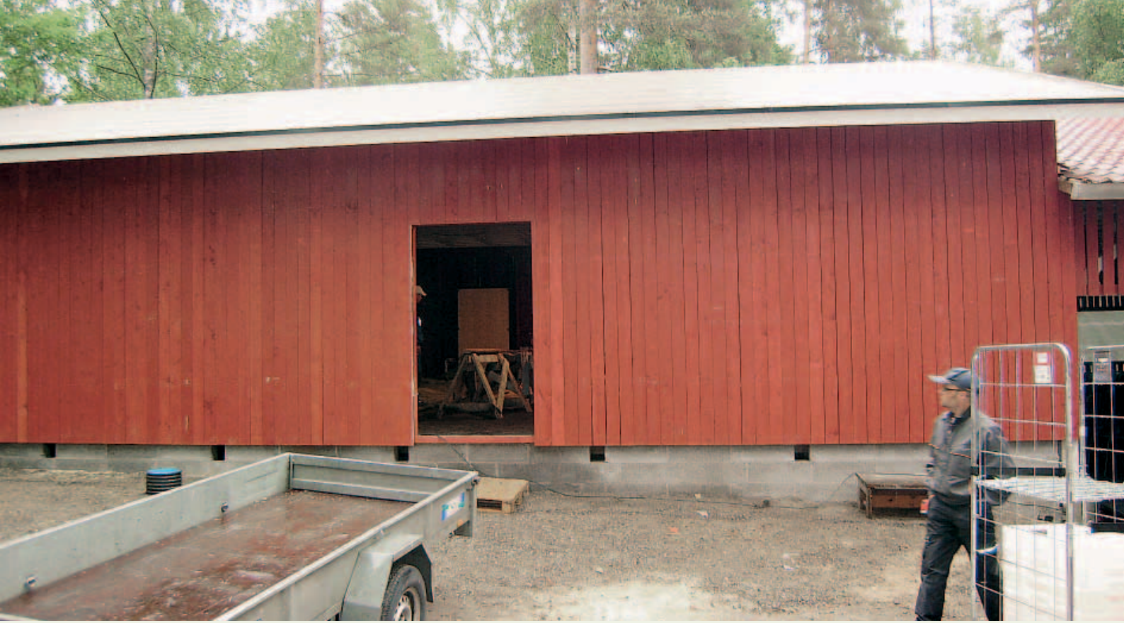
Kesäteatterin laajennus valmistumassa.
