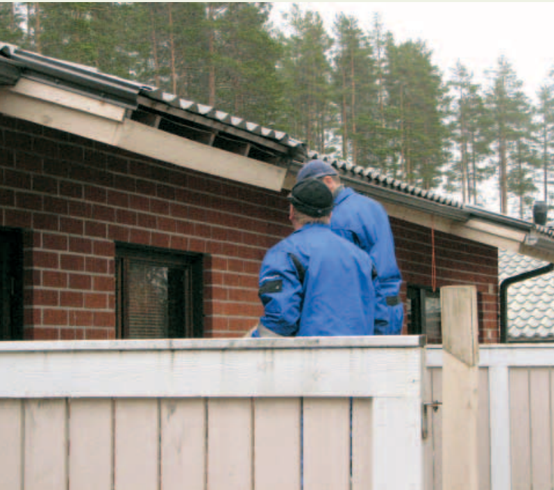
Rivitaloissa kunnostettiin kattojen räystääslaudat ja huoneistojen väliset väliseinämät.
