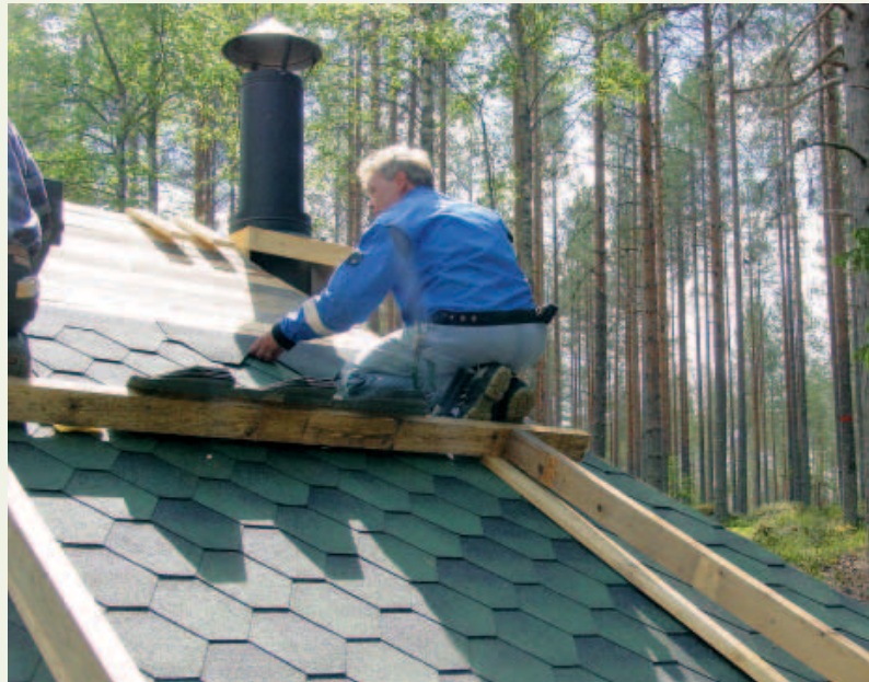
Rakkinekoskelle pystytettiin laavu. Laavun hirret oli työstetty ja numeroitu jo edellisen vuoden koulutuksessa. Työsuunnittelija Emilia Christiansen osallistui rakennustöihin (vas.).
