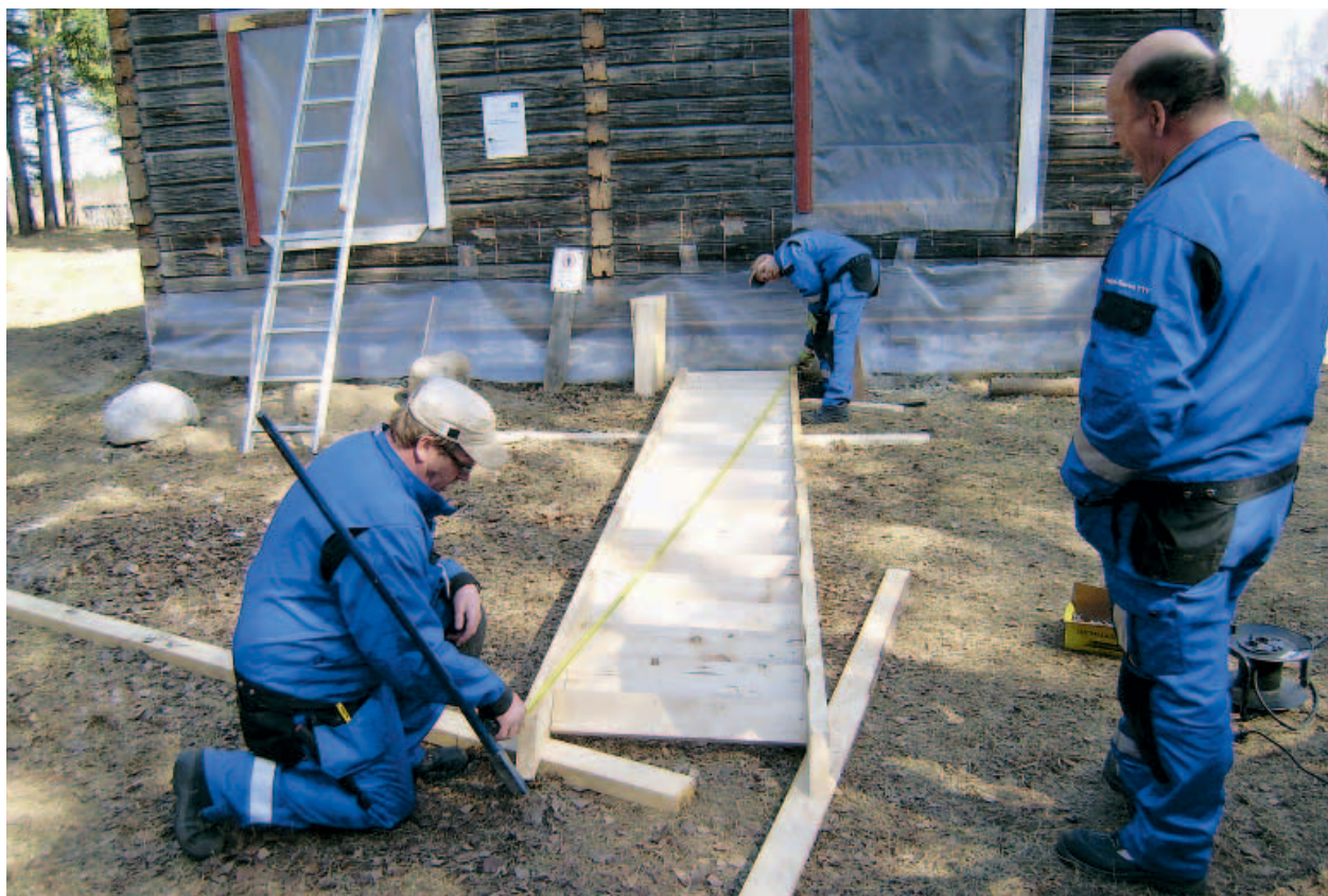
Vanhaa rakennusta kunnostettiin Iisalmessa.
