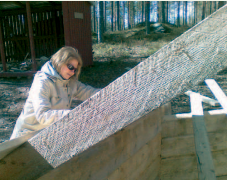
Rakkinekoskelle pystytettiin laavu. Laavun hirret oli työstetty ja numeroitu jo edellisen vuoden koulutuksessa. Työsuunnittelija Emilia Christiansen osallistui rakennustöihin (vas.).
