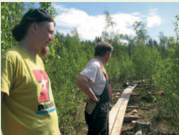
Vesannolla kunnostettiin polkuverkostoa uusimalla pitkospuita.
