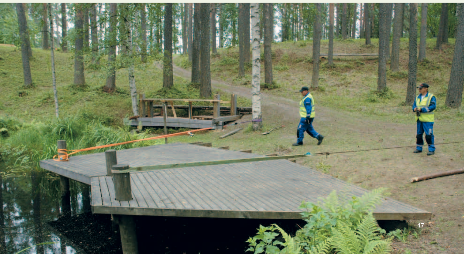
↓ Kaupungintalon takana olevan pienen lammen laituri oikaistiin paikalleen talven jäljiltä.
