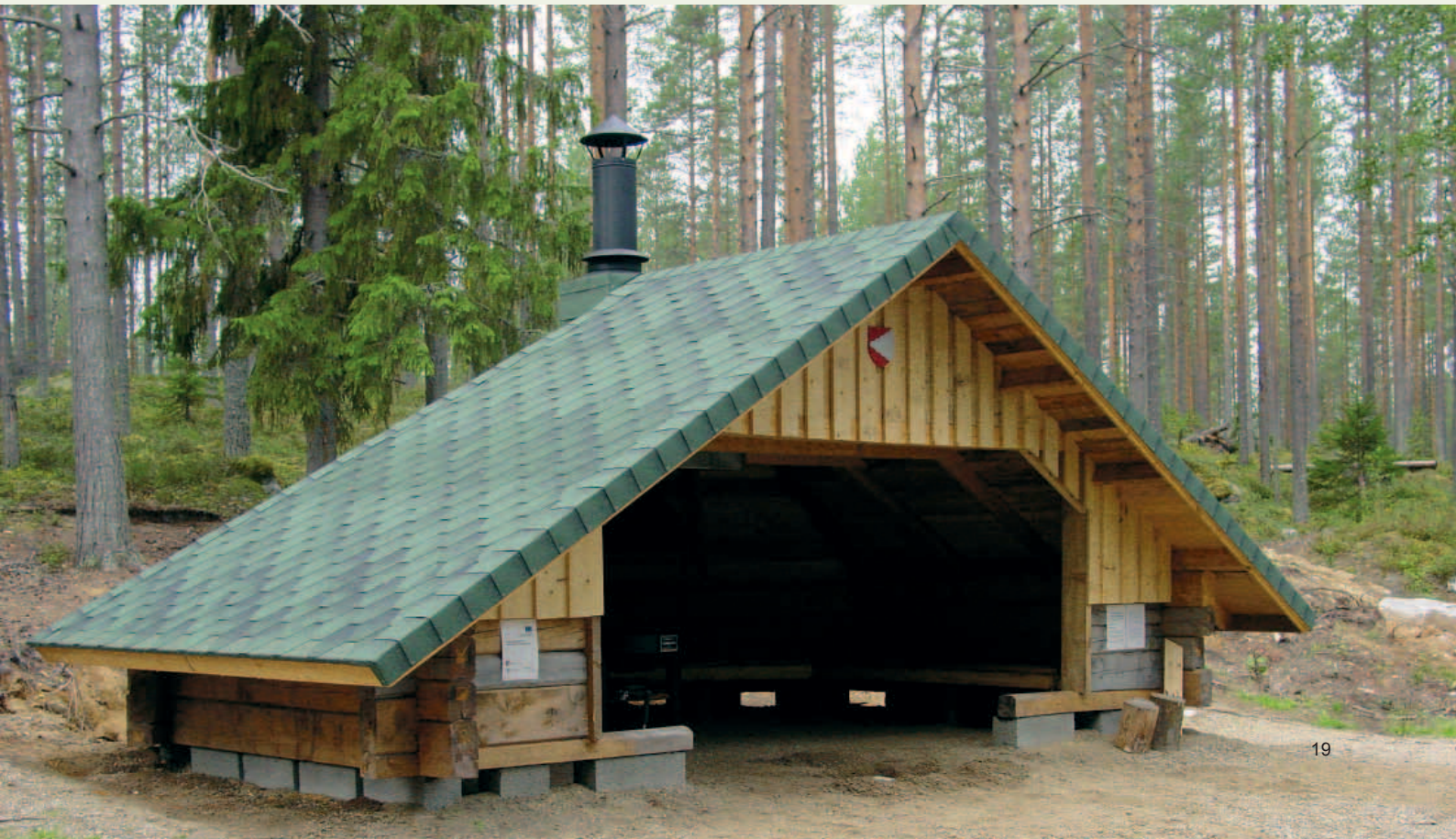
Rakkinekoskelle pystytettiin laavu. Laavun hirret oli työstetty ja numeroitu jo edellisen vuoden koulutuksessa. Työsuunnittelija Emilia Christiansen osallistui rakennustöihin (vas.).
