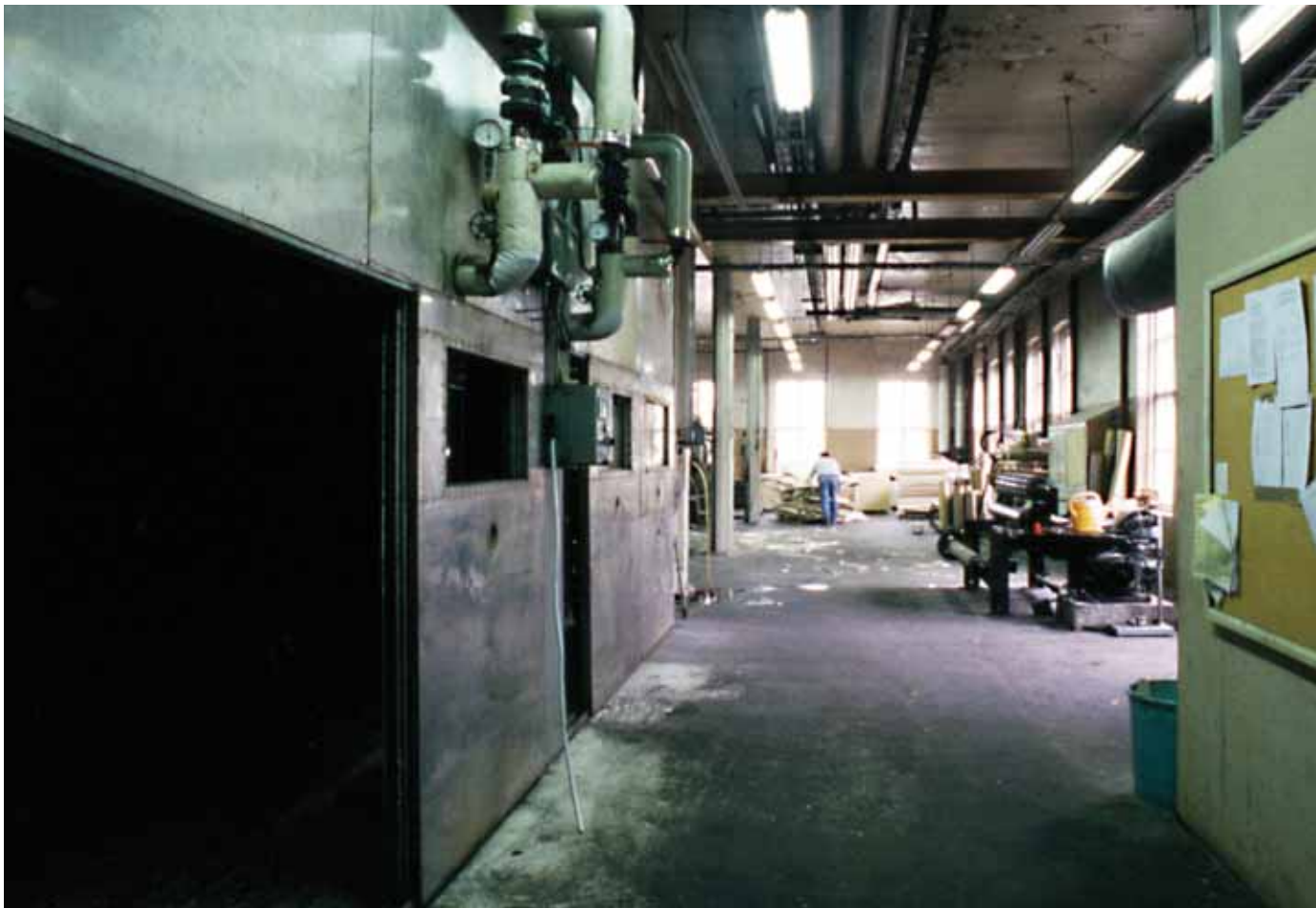
Kuva 25: Kartonkisaliala. Vasemmalla kuivaussyylinterinosaan teräslevyillä päällystettyä seinäkettä. Oikealla näkyy osa taukokuoneen seinästä. Matti Huuhka 1998, Museokuva, MV.
