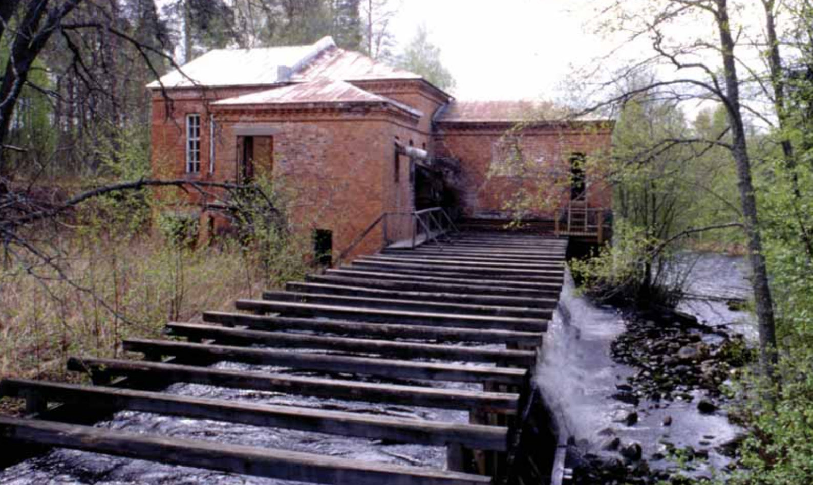
Kuva 30: Alatehdas pohjoisesta. Keskellä kuvaa rakennuksen myllysiipi ja voimakanava. Matti Huuhka 1998, Museokuva, MV.
