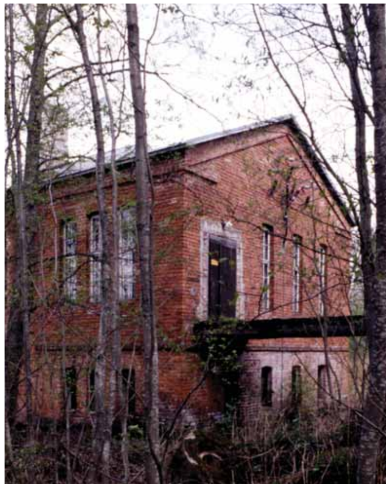
Kuva 29: Alatehdas etelästä. Kuvassa oikealla sisäänkäynti ja puinen kulkusilta. Matti Huuhka 1998, Museokuva, MV.
