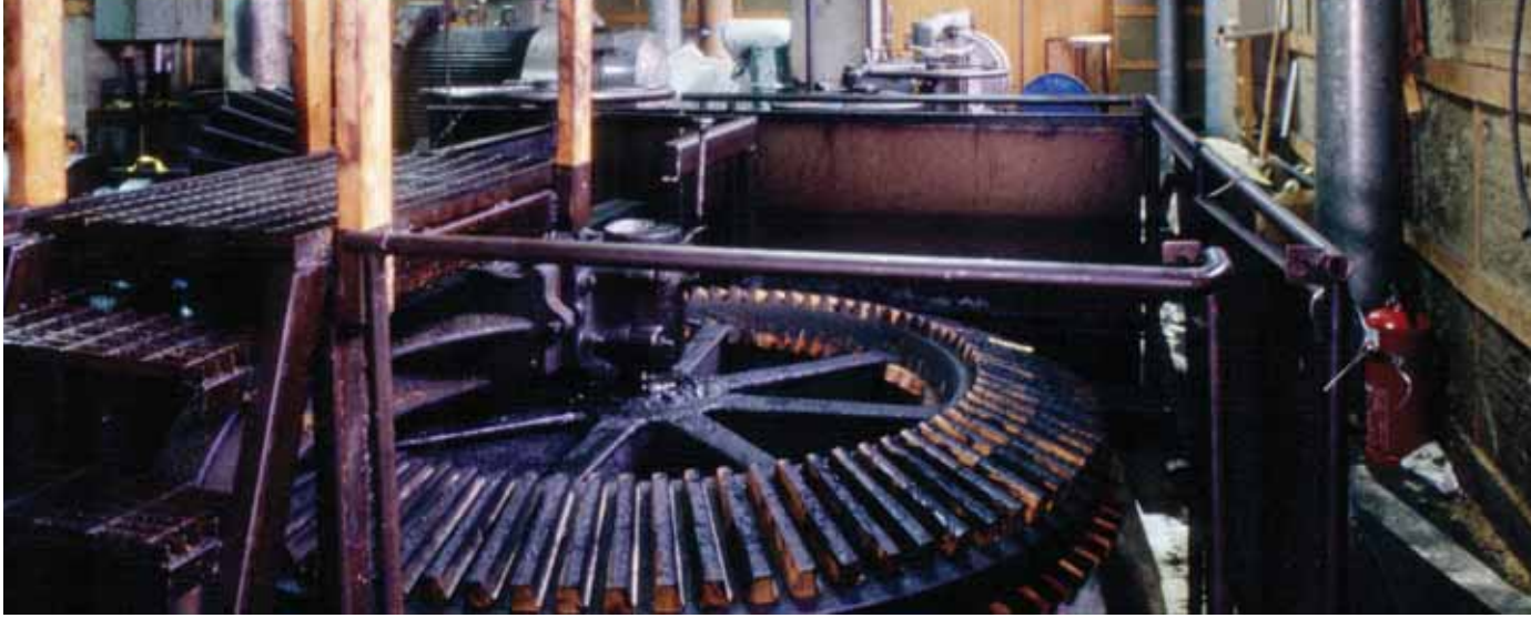
Kuva 9: Tehtaan 1980-luvulla rakennettu turbiinihuone sisältä. Etualalla näkyy vesiturbiinin puinen hammasratas. Matti Huuhka 1998, Museokuva, MV.
