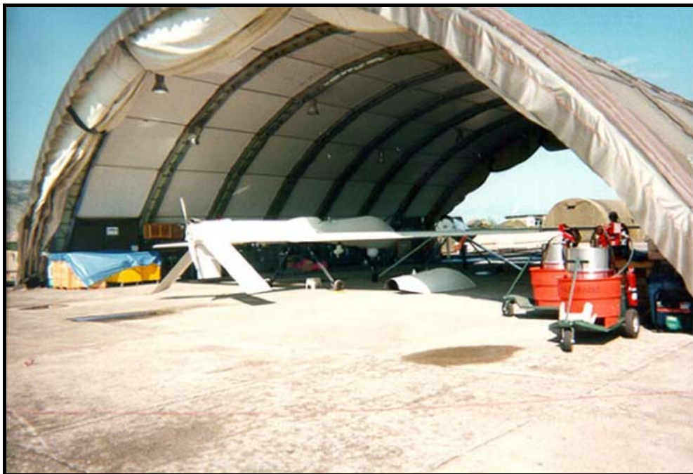
Kuva 3. Konesuoja ja huoltokalustoa.
