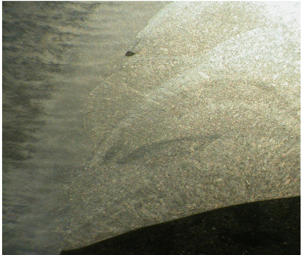
Kuva 53. Koekappaleen NS50 männänvarren ja silmukan hitsausliitos, jossa liitosvirhe on näkyvässä railokyljessä
