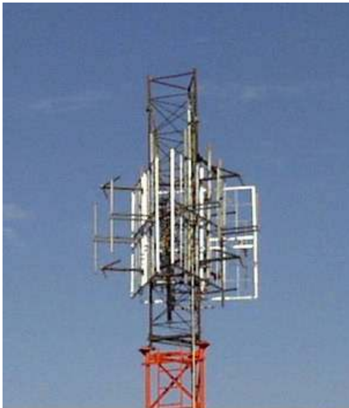
Kuva 4. Ympyräpolaroitu dipolipaneeliantenni (Jampro) [8.]
