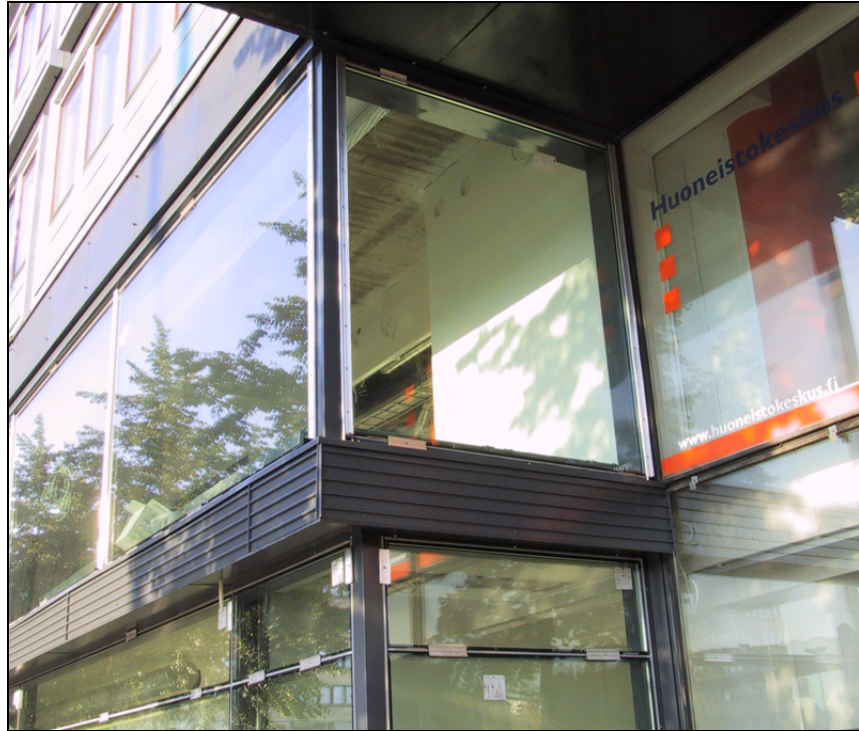
Kuva 3. Huoneistokeskuksen viereinen palolasi EI30.
