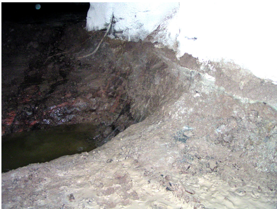
Kuva 2. Vuotovedet virtaavat kuvassa puhtaalla kalliolla, joka kiiltää /7/.
