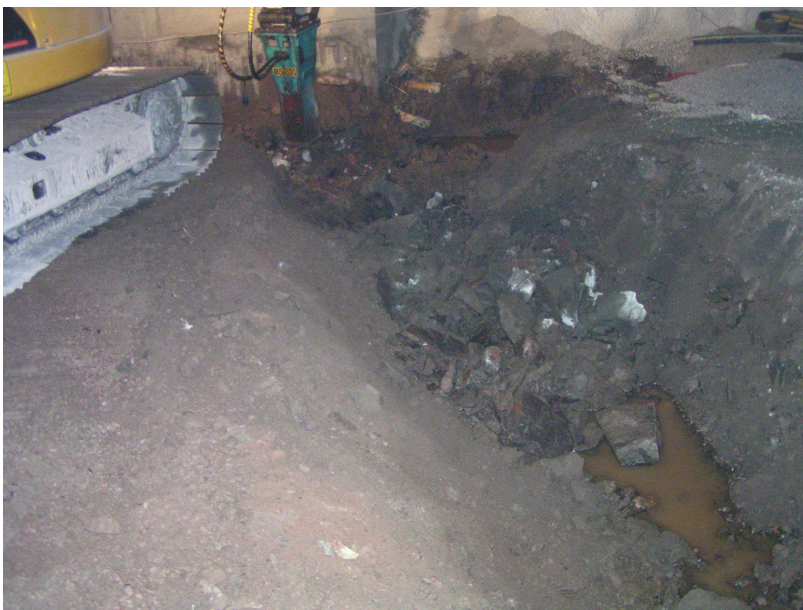
Kuva 5. Kanaalin syventämistä hydraulivasaralla /7/.
