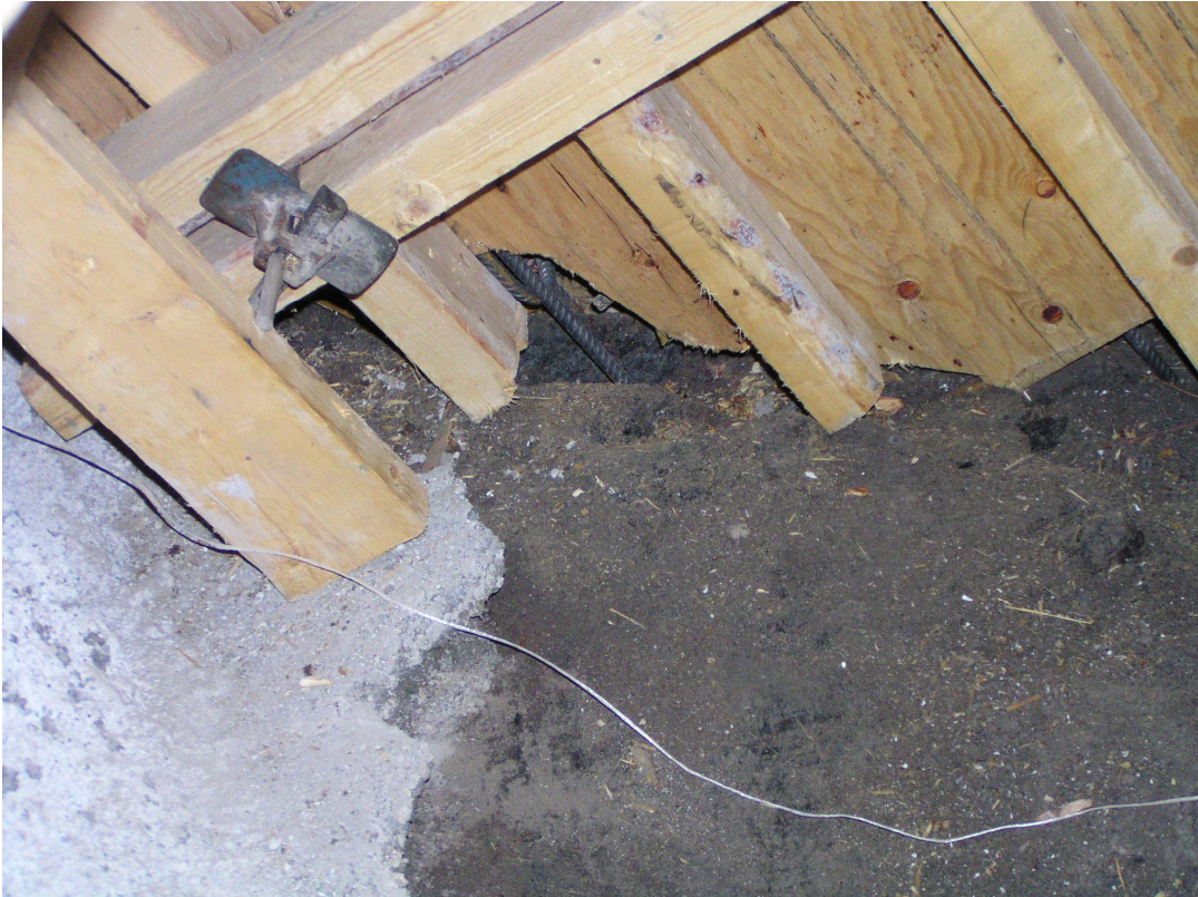
Kuva 8. Muotin ja kallion rajapinta on liian avoin /7/.
