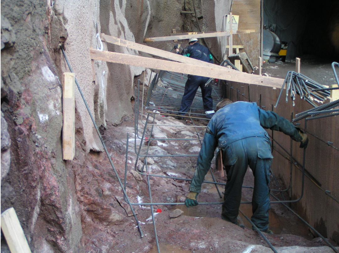
Kuva 4. Kalliopinta on vaihteleva anturan kohdalla 7/.
