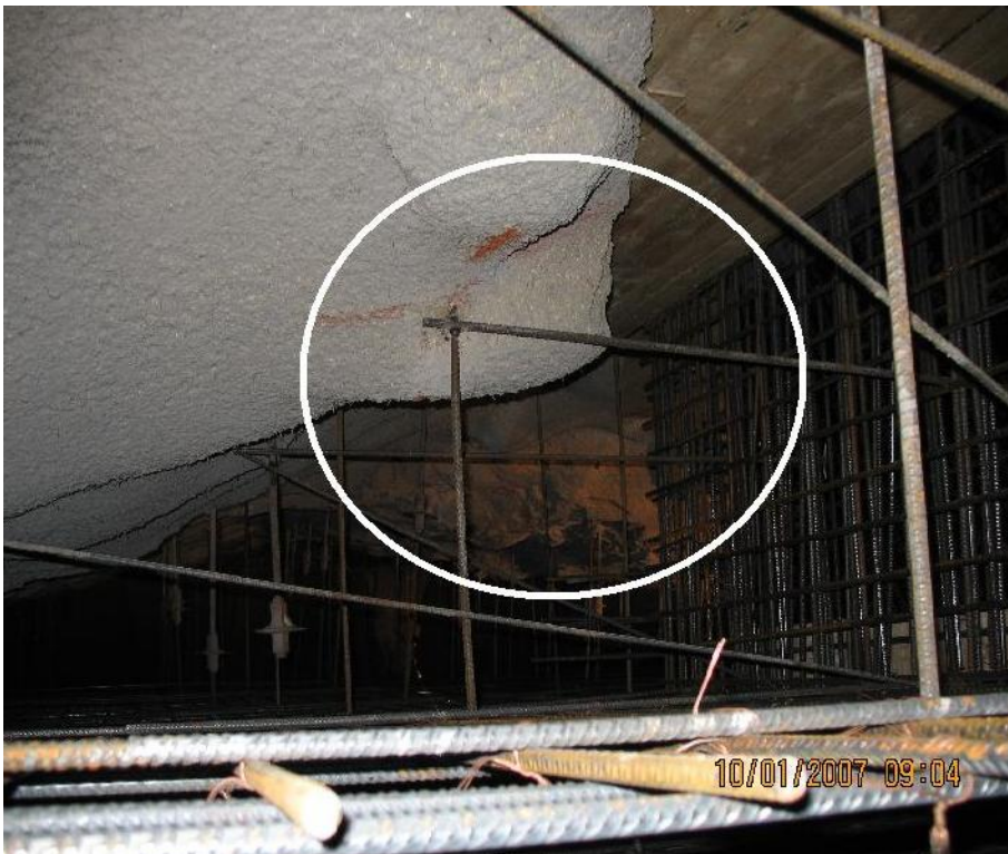
Kuva 10. Muottipulttausta kun sidepultti ei tavoita kalliopintaa /7/.
