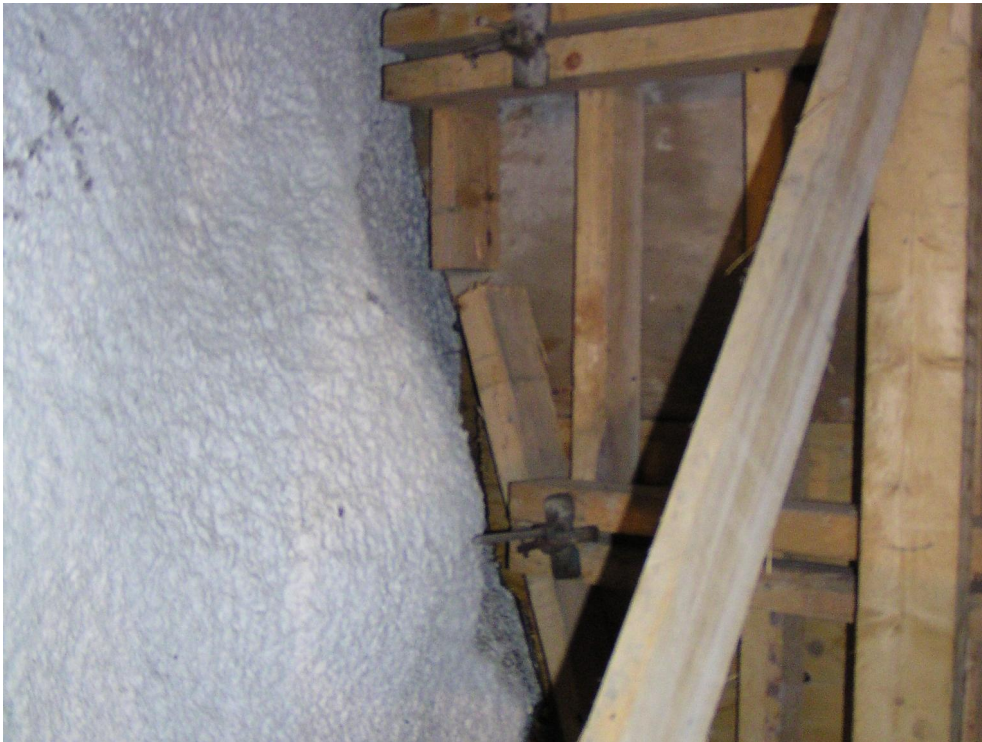
Kuva 7. Tiivisliitos sahatavaramuotin ja kallion rajapinnassa /7/.
