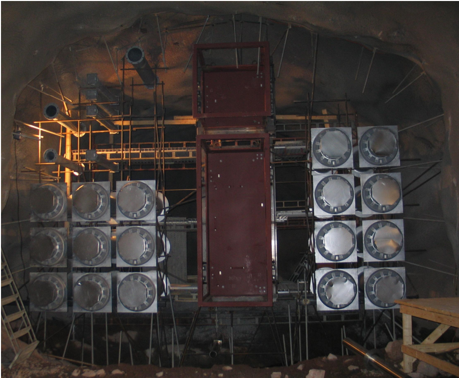
Kuva 16. Kuvassa on läpimenot, niiden asennusteräksset ja tartunta pultit asennettuna /7/.
