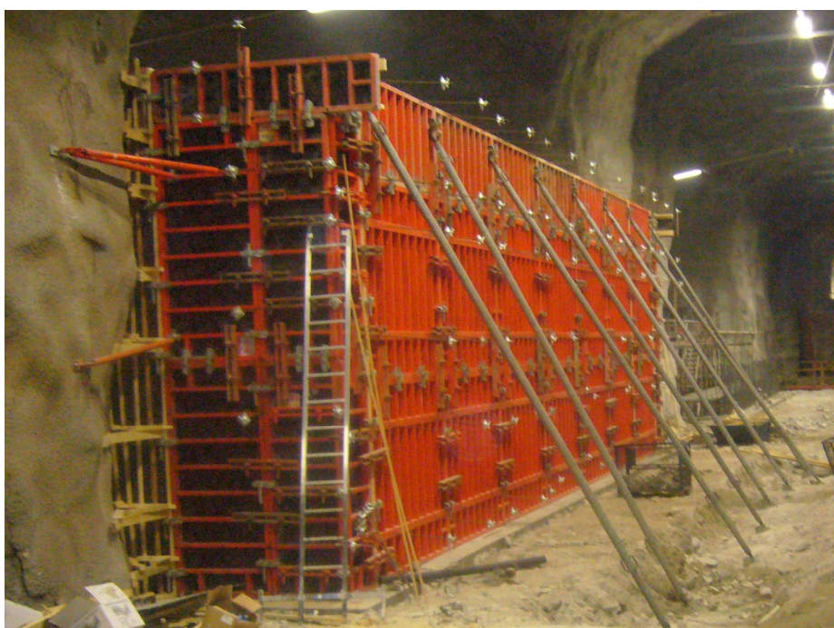
Kuva 6 Järjestelmämuotin ja kalliopinnan väli on yhdistetty tiiviiksi sahatavaralla /6/.
