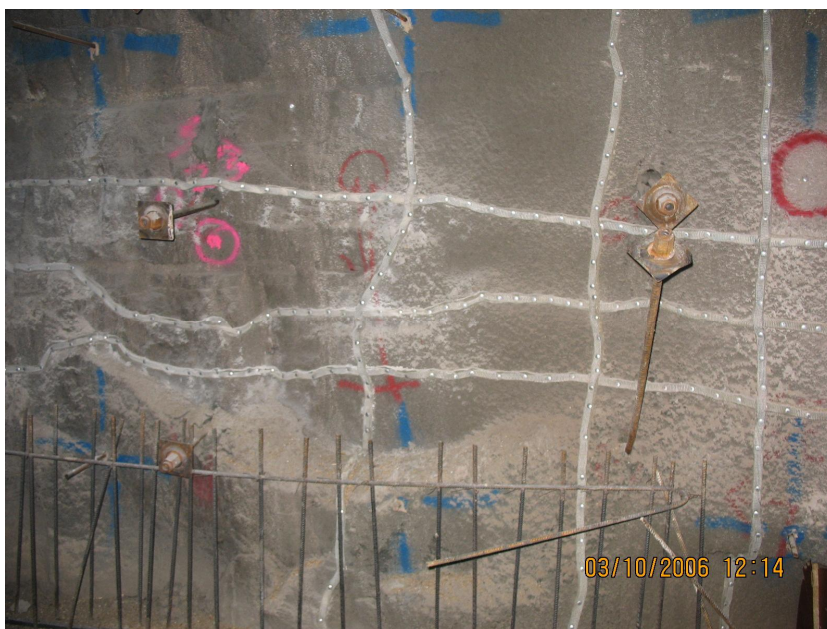
Kuva 9 Vesitiiviin rakenteen kallionvastaisen pinnan tiivistys bentoniittinauhalla /6/.
