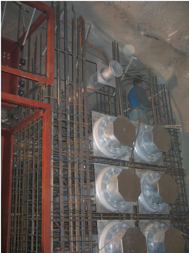
Kuva 13 //. Raudoitustyö on käynnissä, raudoittaja raudoituksen sisällä oikeassa yläkulmassa.
