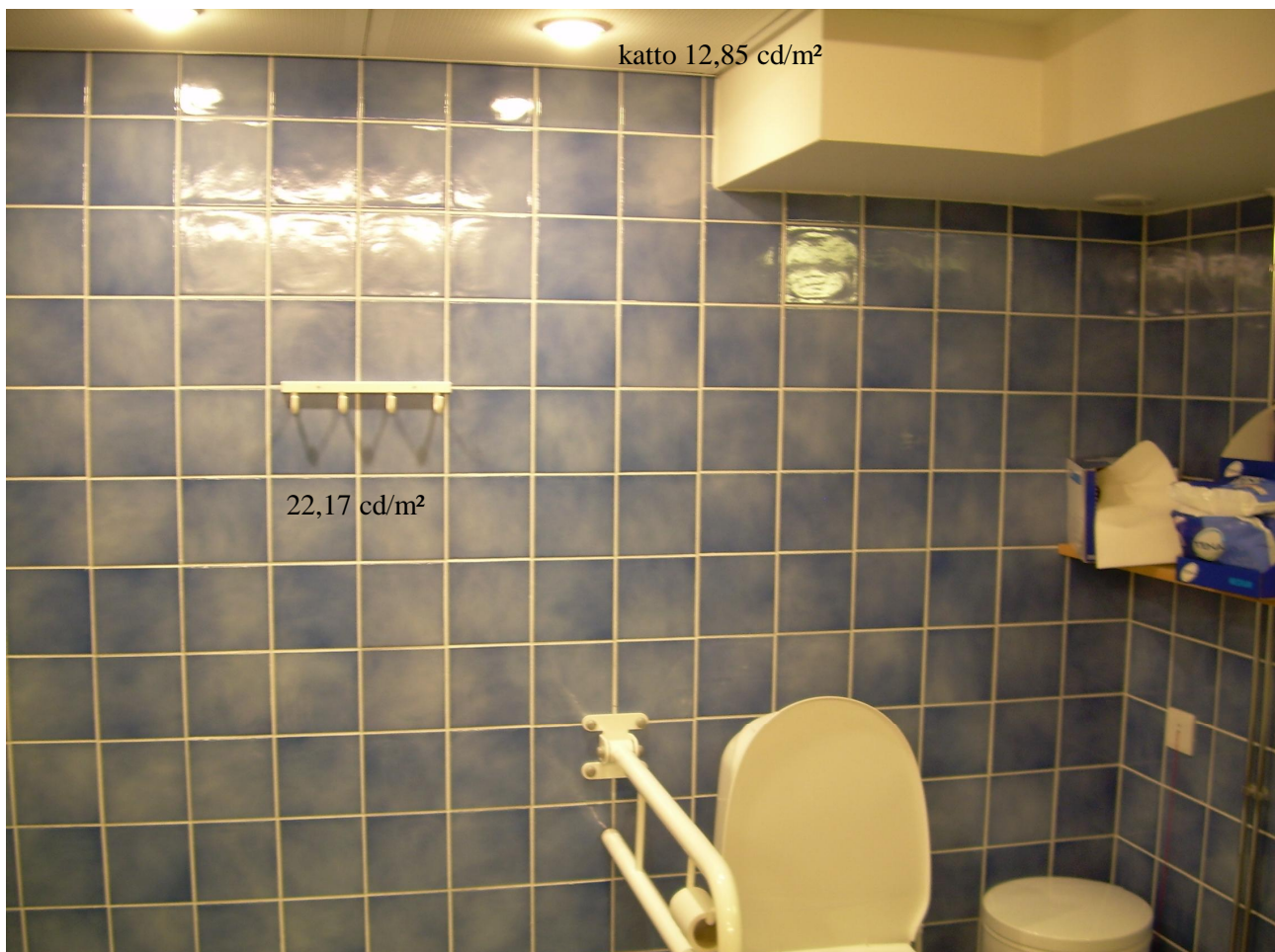
KUVIO 26: Yleiskuva WC-tilasta ja eri näkökohteiden luminanssiarvoja.
