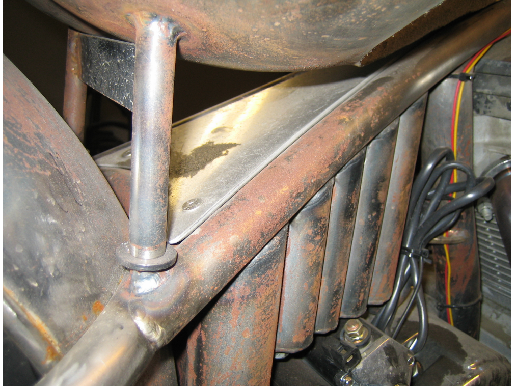
Kuva 12. Releohjain sijaitsee penkin alla piilossa olevassa metallikotelossa.
