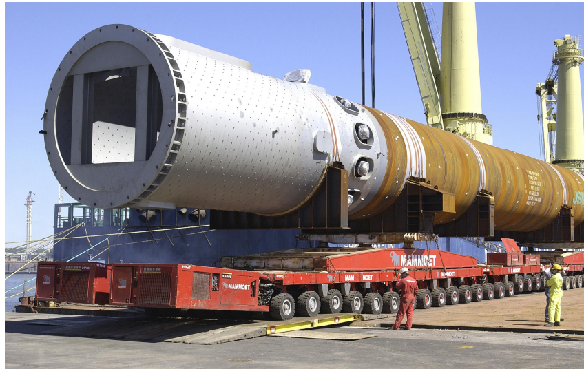
Kuva 8. X-laitteen kuljetus laitostyömaalle. /12/
