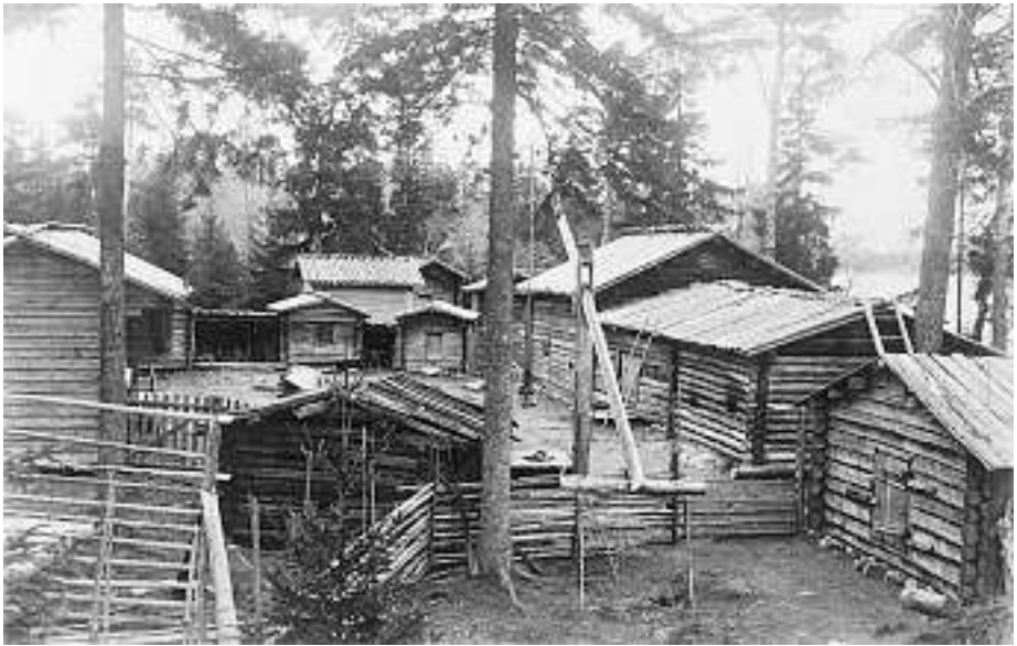
Bild 4. Bebyggelsen på Niemelä torp efter translokaliseringen till Fölisön. På byggnaden framme till höger märks tydligt att väggarna tätats med mossa. Stegarna vid följande byggnad tyder på att byggnadsarbete pågår. Bilden såldes som vykort i början av 1900-talet. Foto: Museiverkets bildarkiv.
