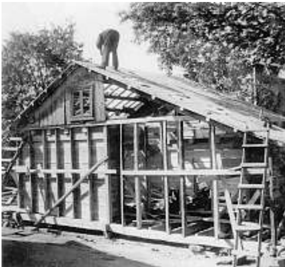
Bild 47. När fastigheten 172 övertogs av museet, var gårdsbyggnaden i så dåligt skick att den måste byggas upp av nytt virke. "Endast brädfodringen är original" står det antecknat i dokumentationen av nybyggnaden. I det ursprungliga huset (jfr bild 8) fanns "Nässelplockerskans bostad" som nämns i Ludvig Lindströms pamflett 1913.
