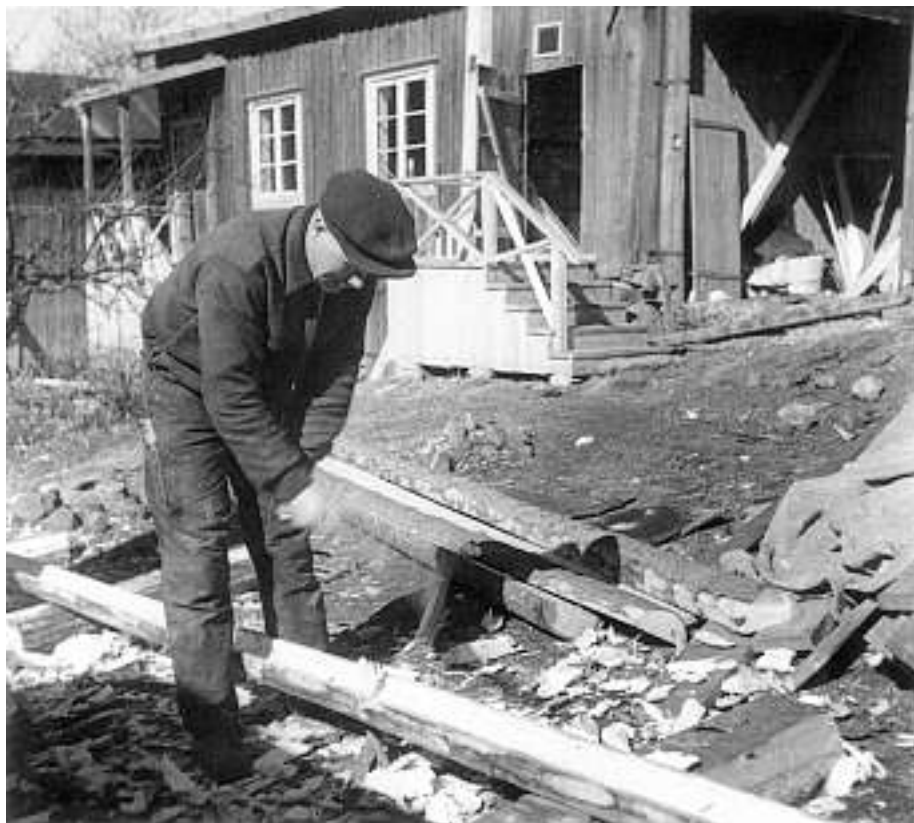
Bild 50. Då det på Klosterbacken använts takrännor av urholkat trä, tillverkades nya för museets behov. Till urholkningen används en yxa med bågformat brett, som står i vinkel mot skaftet, i motsats till en huggyxa, vars brett går parallellt med skaftet. Foto: ÅLM/Irja Sahlberg 1939.
