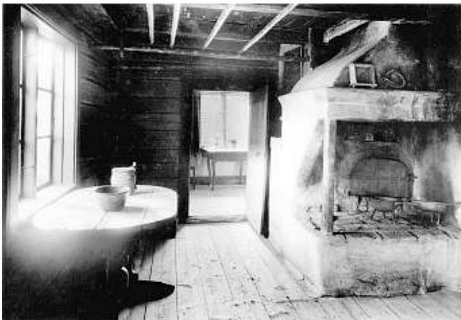
Bild 54. Interiören i gårdsägarens bostad i nr 183 planerade Irja Sahlberg utgående från en intervju med en kvinna som bott där på 1860-talet. Den öppna spisen (jfr bild 49) återställdes och brödspetten på bäråsarna i taket likaså. Foto: ÅLM/Pietinen 1940.
