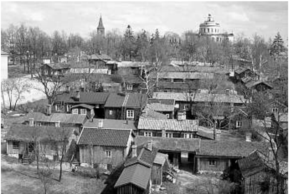
Bild 1. Hantverksmuseet på Klosterbacken sett från söder. De mörka husväggarna vittnar om hur brädfodringen patineras av sol och väder när husen lämnas omålade. I förgrunden syns torvtaken på de hus som restaurerades på 1960-talet. Högst uppe på backen skymtar stentaken på gårdarna 183 och 176. En stor del av tegeltaken har lagts för att öka brandsäkerheten. Foto: ÅLM/Tom Bergroth 1973.
