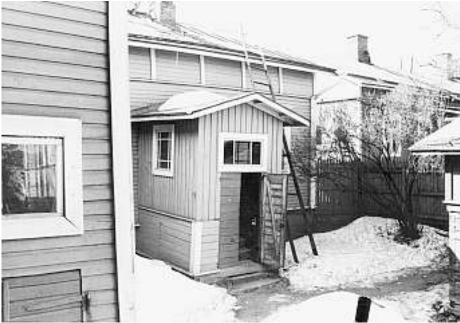
Bild 44. Gården 41 sedd från gårdssidan. Utom gårdsägarens bostad på tre rum och kök innehöll huset 11 hyresrum och en källarlokal. Den öppna farstudörren leder till samköket från 1930-talet. Hur trång gårdsplanen är märks på det korta avståndet mellan farstuvisten och uthuset t. h. Foto: TMA/Mikko Helin 1981.
