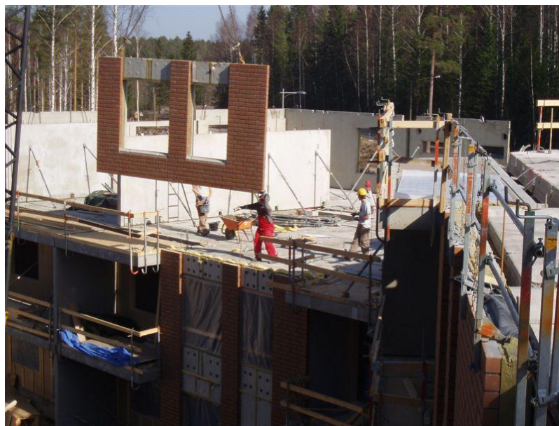
Kuva 2: Asianmukaista elementtiasennusta./5./
