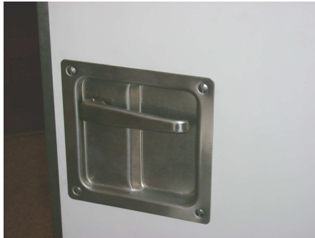
Kuva 1. Upotettu painike ovessa
