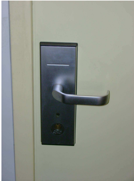
Kuva 2. Avainkortinlukijallinen lukkolaite
