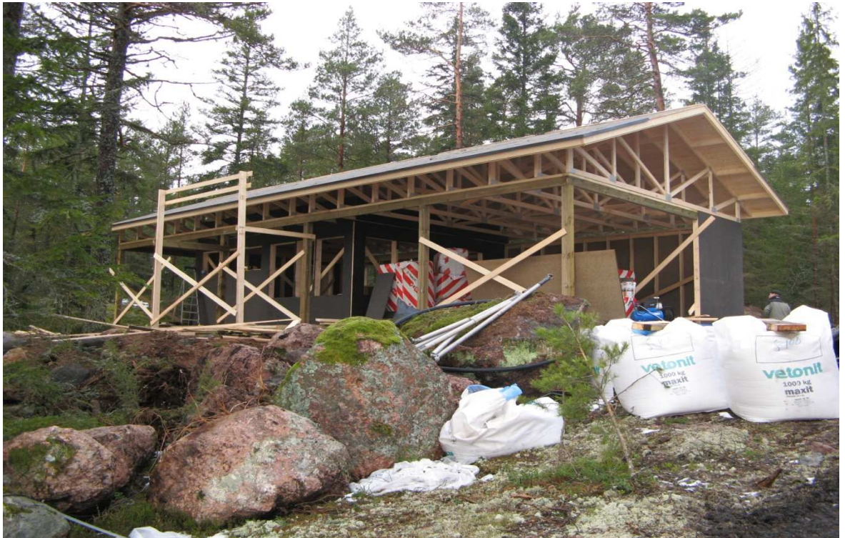
Bild 15. Byggandet av bastubyggnaden
