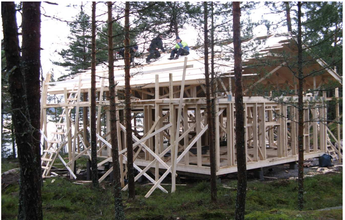
Bild 16. Byggandet av taket på stuga
