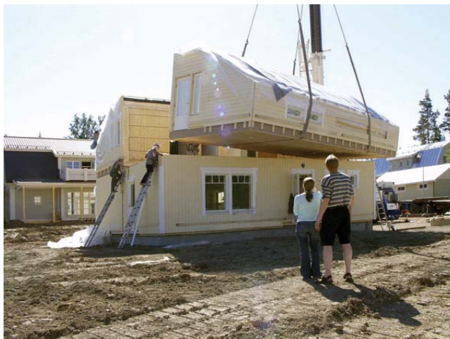
Kuva 5. Tilaelementit asennetaan paikoilleen lähes valmiina asuttavaksi.
