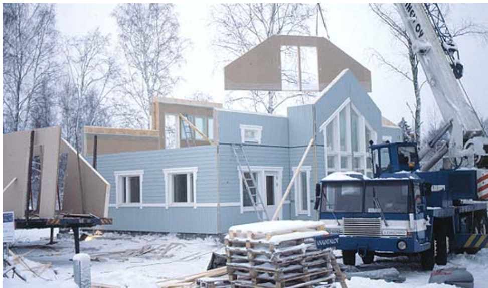
Kuva 3. Suurelementit tuodaan työmaalle suurina elementteinä ja nostetaan nosturilla paikoilleen.
