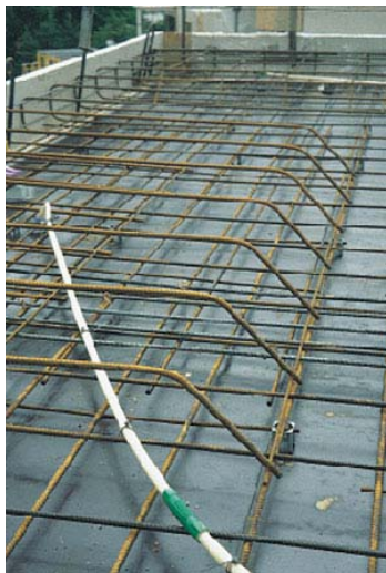
Kuva 2. Tyypillinen taivutettu betonirauhoitusverkko
