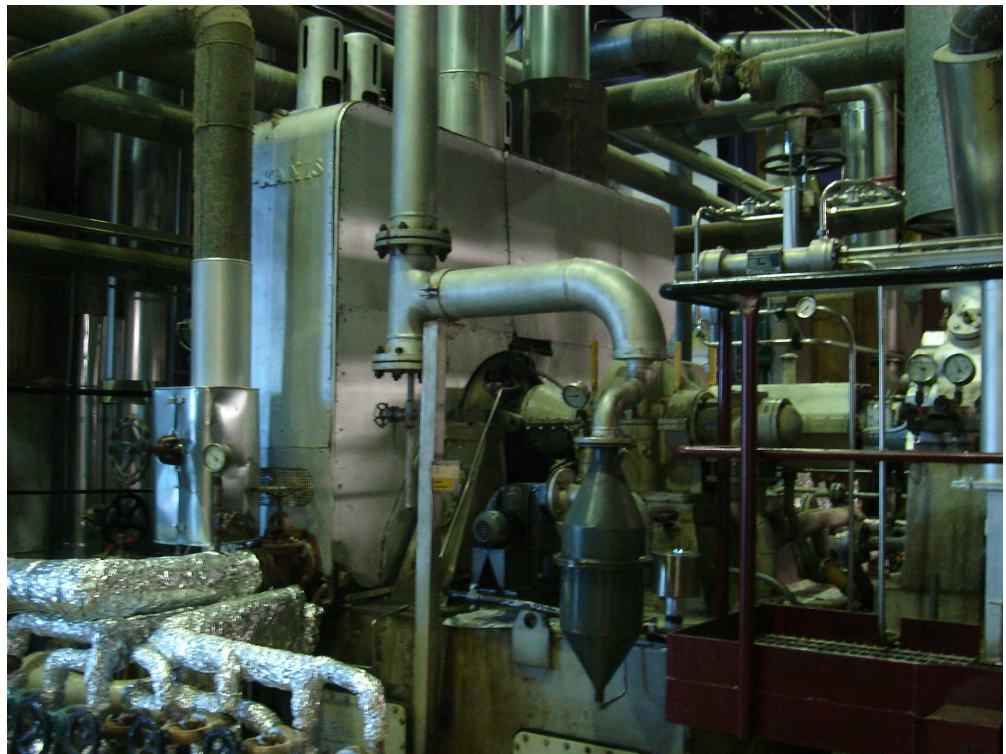
Kuva 5. Nykyinen primäärpumppu. AEG Kaniksen keilasäädetty vastapaineturbiini.
