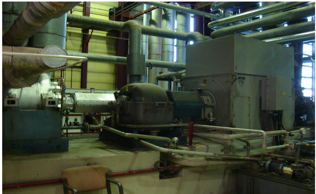
Kuva 4. GA-14022S, nykyinen varapumppu. Pumppua pyörittää Brown, Boveri & Companyn 3 megawatin sähkömoottori
