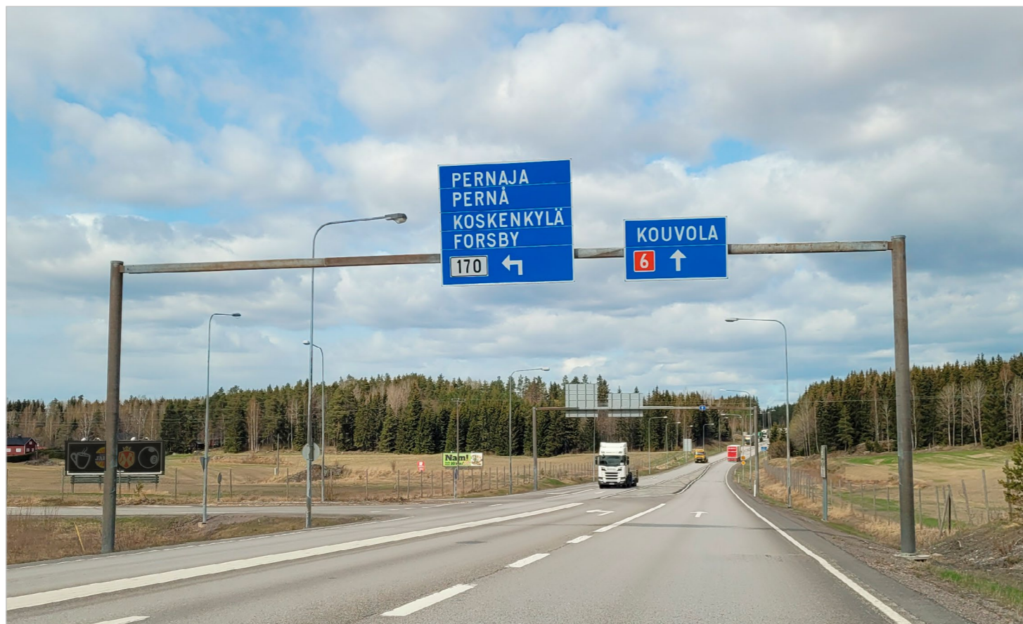
Kuva 1.2. Valtatie 6 ja maantien 170 Loviisiantien välinen liittymä kuvattuna etelästä päin.
