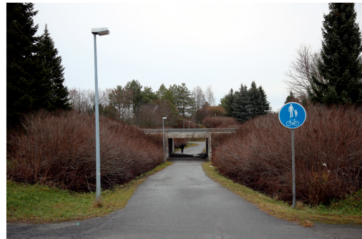
Kuva 1–3. Kullervon alikulkukäytävä suunnittelualueella.
