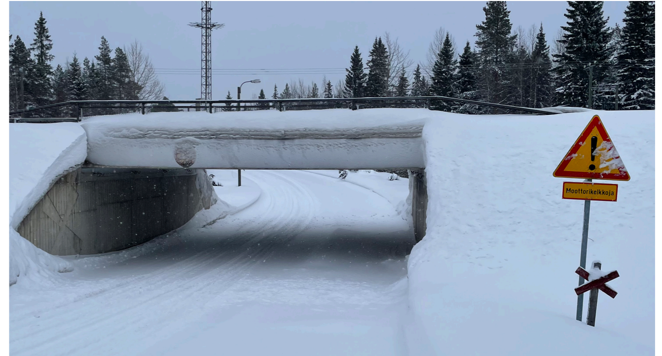
Kuva 29. Valtatie 4 alittava alikulku Kotivaaran suuntaan.
