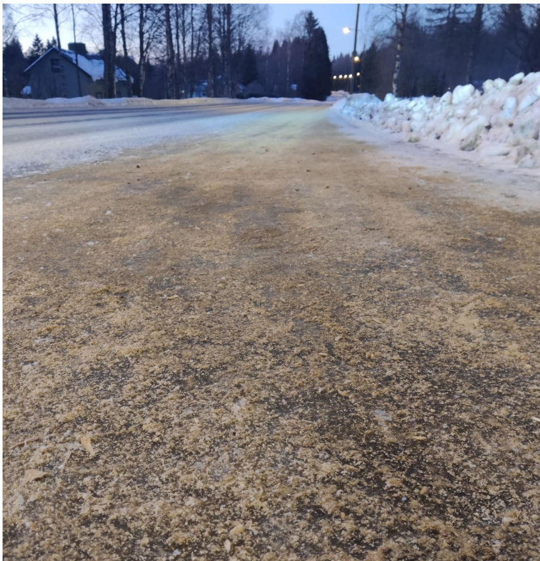
Kuva 18. Kortteisentie kävely- ja pyöräilyväylä 27.1, puru. Puru tarttunut pintaan erinomaisesti.
