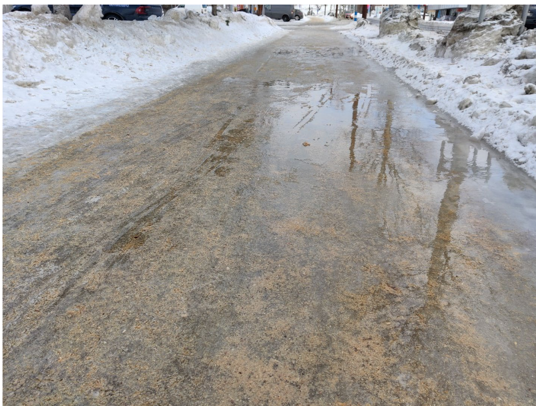
Kuva 36. 573 kävely- ja pyöräilyväylä, puru. Puru ei juurikaan kellu vesilätäkössä.
