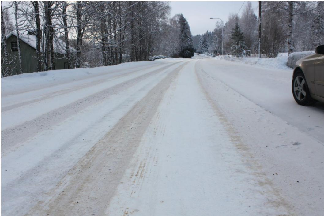
Kuva 8. Kortteisentie ajorata 23.1, puru levitettyä tielle.
