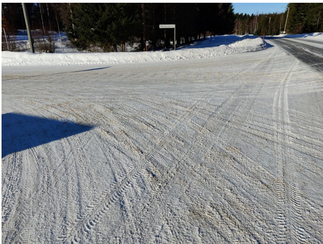
Kuva 26. Miетtilänmäentie liittymä 28.2, puru.
