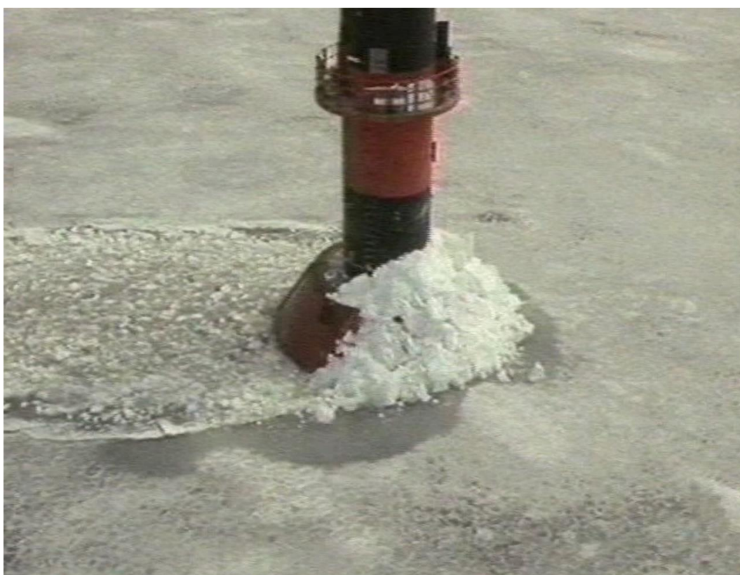
Kuva 19. Jää murtuu pääosin leikkautumalla Kemi 1 kartiota vasten /18/.
