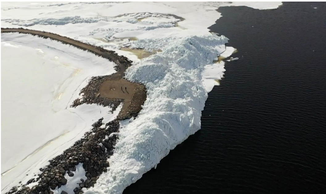
Kuva 22. Kevätjää on kasautunut kovassa tuulessa aallonmurtajaa vasten Hailuodon Marjaniemessä (kuvakaappaus YLE:n arkistofilmistä).
