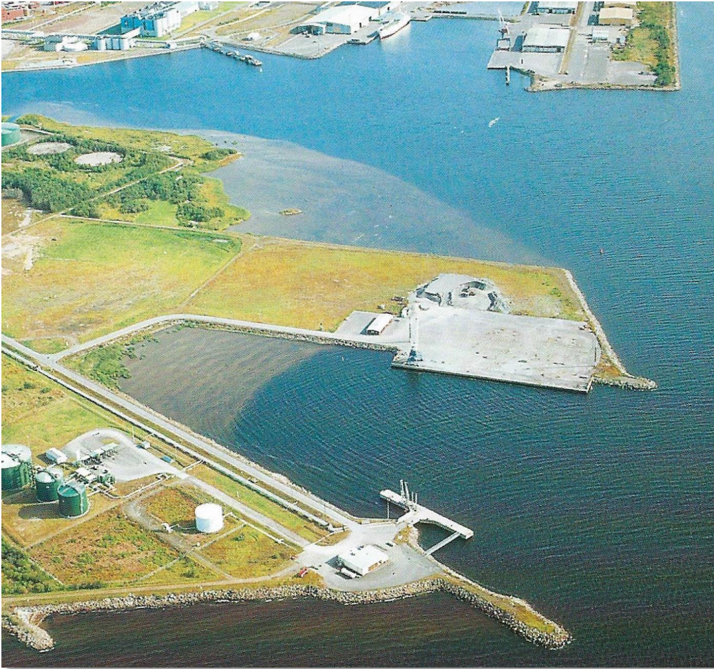
Kuva 8. Vedenkorkeuden muutoksien synnyttämä halkeilumekanismi on vaurioittanut paaluille perustettua öljylaituria Oulun Vihreäsaarella. Kun jää laivapaikoissa murretaan, vastavoimaa ei synny.
