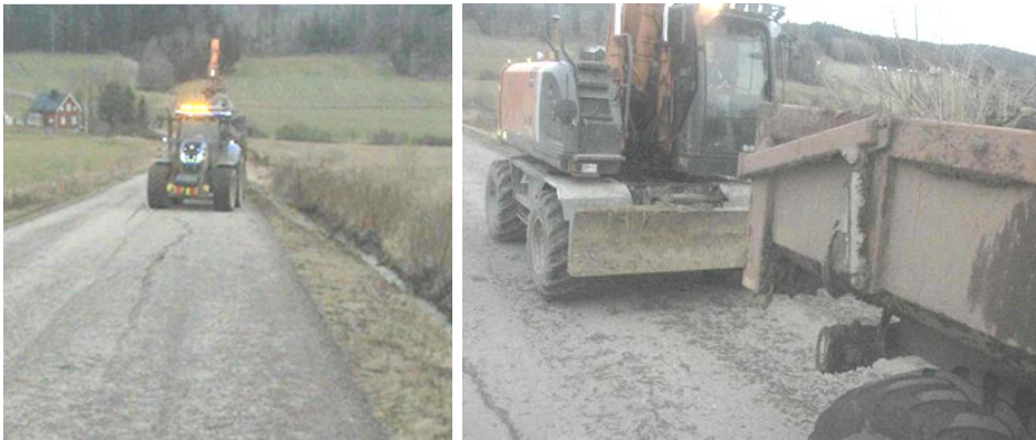
Kuva 18. Kaivutyön toteutusta syksyllä 2022.
