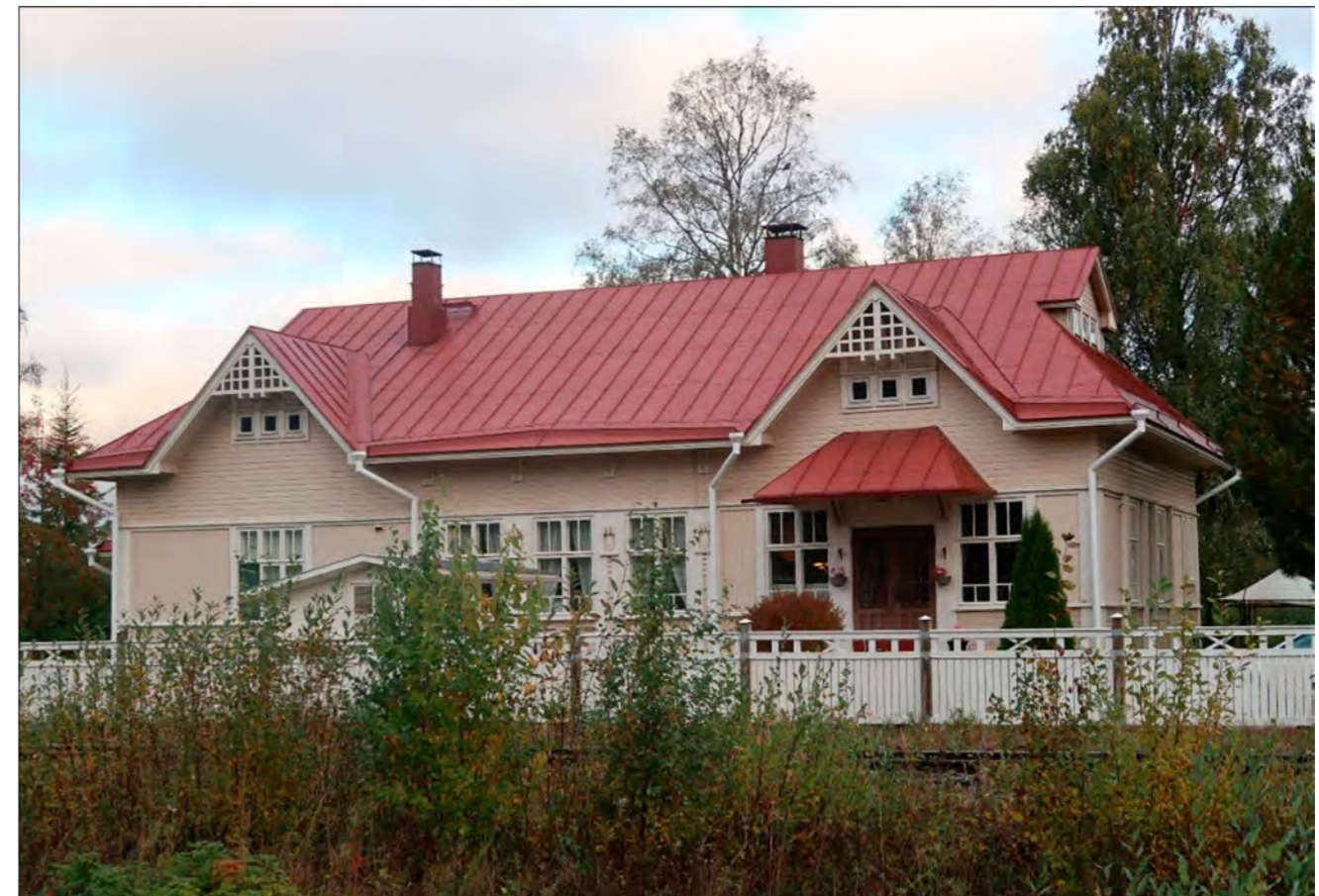
Kuva 7-8. Ilmajoen rautatieasema on valtakunnallisesti merkittävä rakennettu kulttuuriympäristö.
