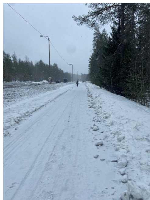
Kuva 50. lumisateen seurauksena urautuneet kohdat muuttuivat vaaralliseksi, kun lumen alta väylän epätasai- suutta ei voinut havaita.
