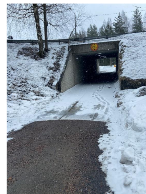
Kuva 52. luminen ja jäinen alikulku, jossa sataneen lumi- kerroksen alla oli ohut jääpeite ja sen alla vettä
