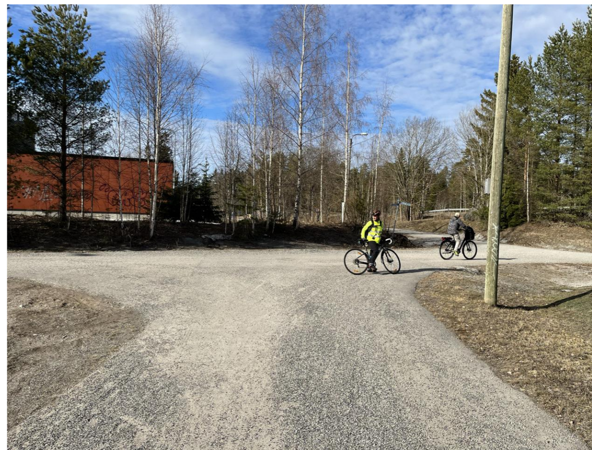
Kuva 55. Hollolassa oli talvikunnossapitoon käytetty paljon hiekoitushiekkaa. Lumien sulettua hiekka muodosti paikoin paksuja kerroksia, jotka olivat etenkin mäissä ja mutkissa liukkaita
