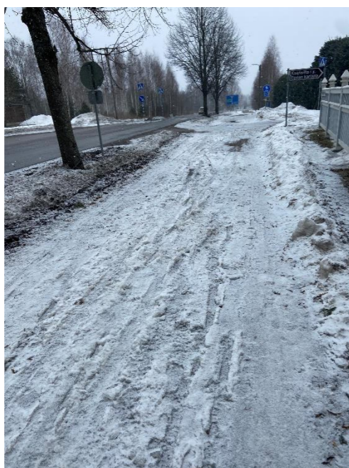
Kuva 49. kohta, josta lunta ei ollut poistettu ja se oli nol- lan tuntumassa sahanneen lämpötilan takia pahasti urau- tunut
