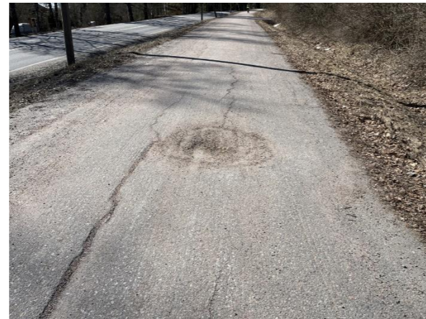
Kuva 25. Kuoppa pyörätiessä Uudenkylän pääpyöräreitillä
