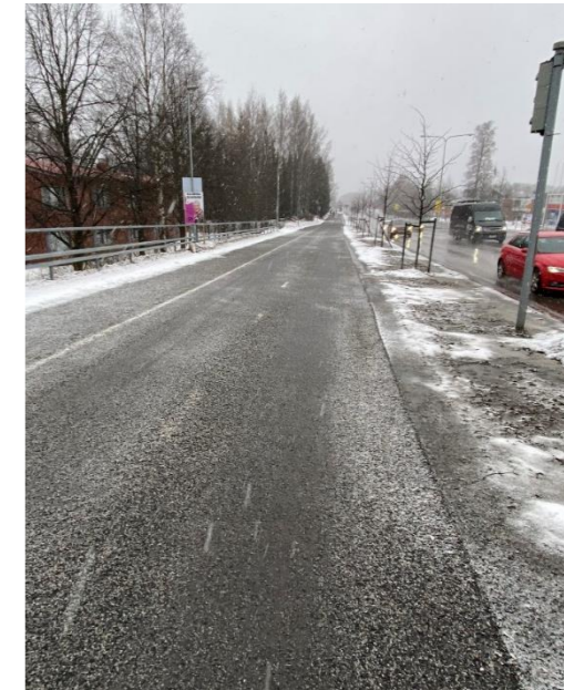
Kuva 48. Kun hiekoitushiekkaa ei ollut käytetty niin paljon tai sitä oli poistettu, tienpinta ei sohjoontunut, koska lumi ja räntä sulivat siihen osuessaan.
