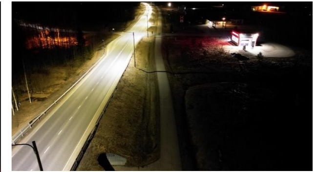
Kuva 34. Katuvalaistusta Orimattilassa. Katuvalaistus ei riitä valaisemaan pyörätietä etenäkään alikulun kohdalla
