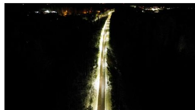
Kuva 42. Pyörätie siirtyy omaan maastokäytävään Levon hautausmaan kohdalla. Tällä osuudella valaistuksen laatu on erinomainen
