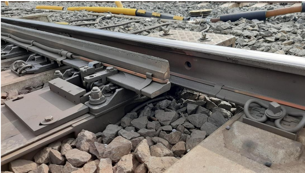
Kuva 49. Vaihteen V330 suoran tukiksiko ja käyrä kieli, joiden kulkureunalla näkyy pyörien laippojen kuljettama voiteluaine.
