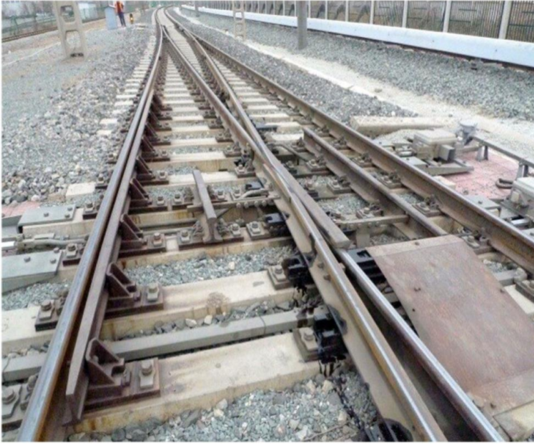
Kuva 4. Poikkeavan raiteen risteysalueen liikkuva ja korotettu siipikisko ja kielirakenne (movable grade-separated crossing). (Wang 2015)
