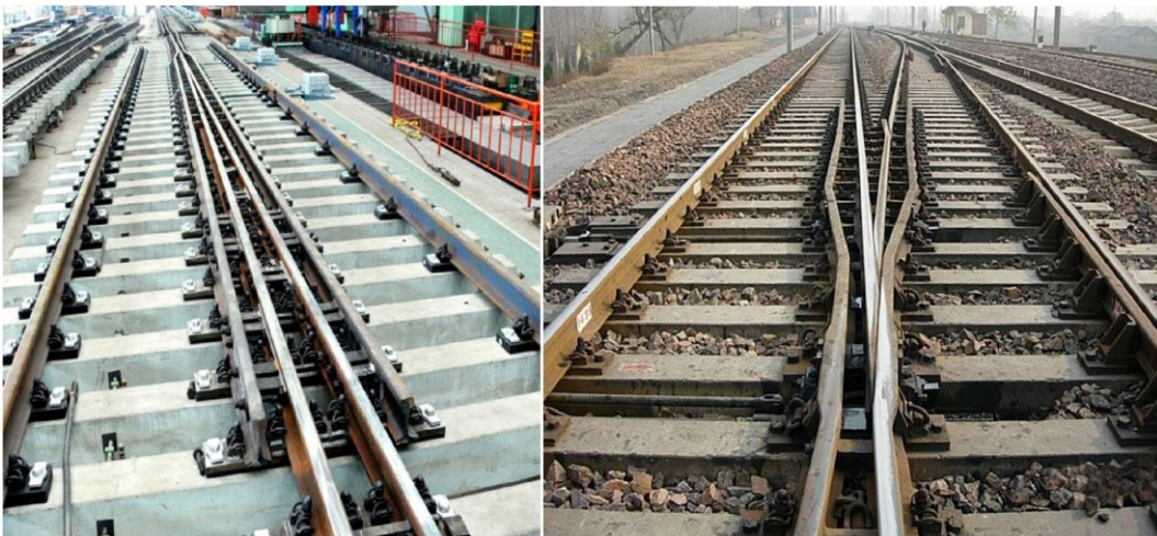
Kuva 5. Suurnopeusvaihteen kääntyväkärkisen risteuksen eri rakenteet. Vasemmalla perinteinen kääntyväkärkinen risteys kummankin risteyskiskon
