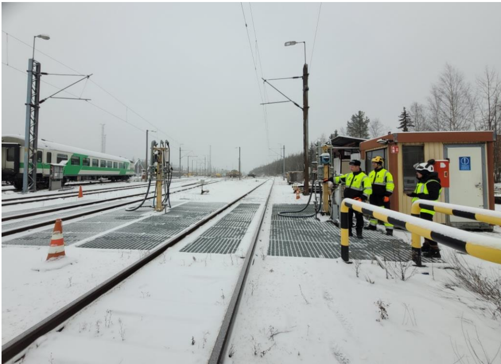
Kuva 3. Raiteiden R996a ja R993 eteläpäässä sijaitsevat polttoaineen jakelupaikat.
