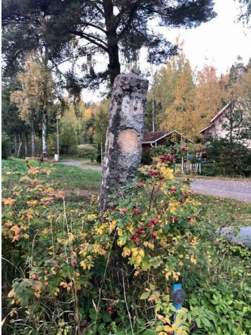
Kuva 14. Punkalaidun-Urjala-tie on Suomen historiallisia teitä. Sen nykyisen linjauksen varrella on säilynyt tämä pylväs. Se voi olla jopa Venäjän kilometrimittauksen ajalta tai aivan Suomen itsenäisyyden alkuvuosoilta. Tienumeron kenttä on hakattu vuoden 1938 tienumerouudistuksen yhteydessä. Kuva Heidi Rytky.
