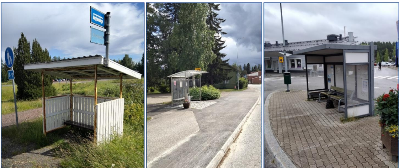
Kuva 4. Maastokäynneillä kartoitettuja pysäkkikatoksia: Revonlahti L, Pulkkila P ja Sotkamo linja-autoasema.
