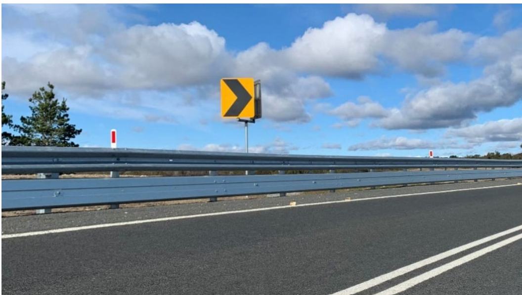
Kuva 4. MPS järjestelmä (Safe Directions crash barrier solutions).
