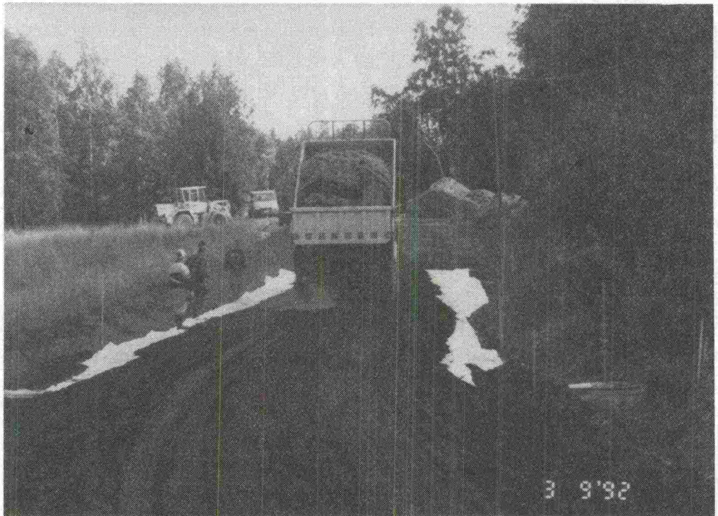
Kuva 14: Voimalaitostuhkan levitystä.
