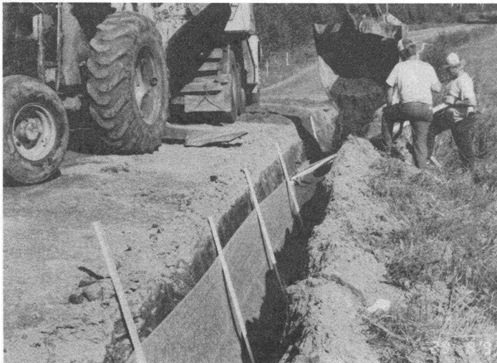
Kuva 22: Hydromattokaivannon täyttötyötä.
