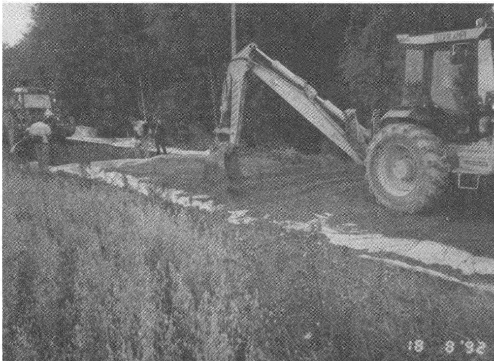
Kuva 29: Murskeen levitystä kevytsorakerroksen päälle.
