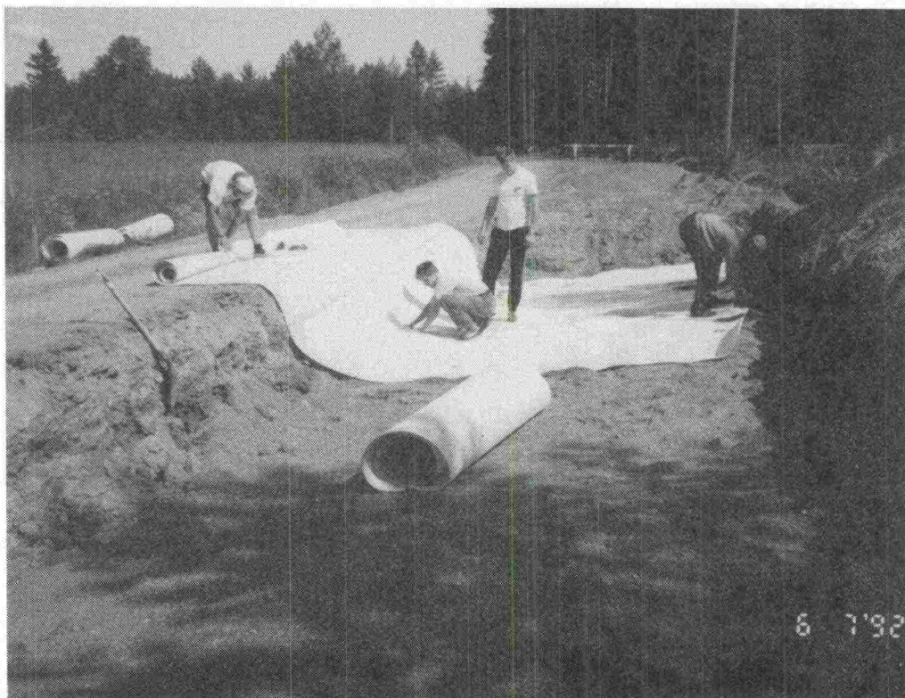
Kuva 27: Salaojamaton asennustyötä.
