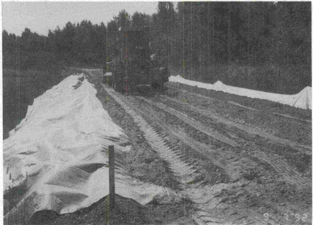
Kuva 11: Biotiitti-murske massan levitys käynnissä.
