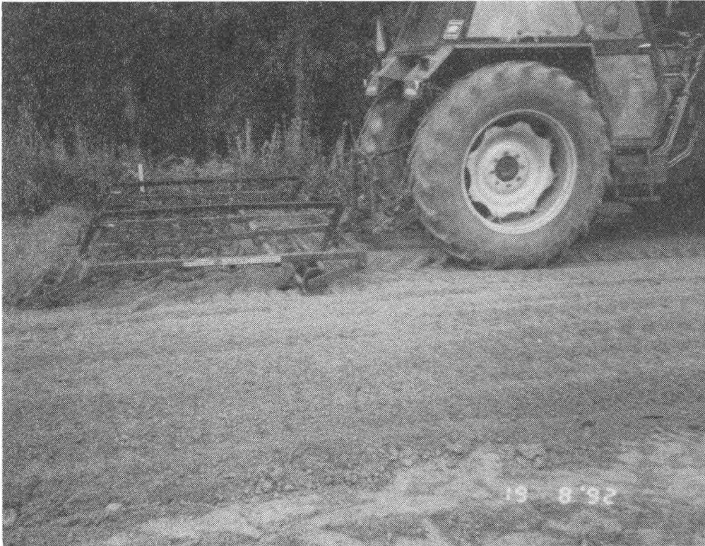
Kuva 17: Sideaineen sekoitusta jousiäkeellä.
