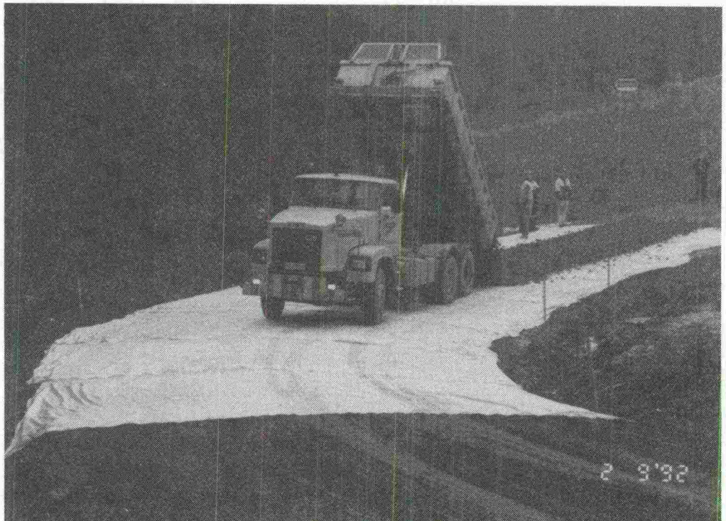
Kuva 4: Murskekerroksen rakentaminen geovahvistematon päälle.
