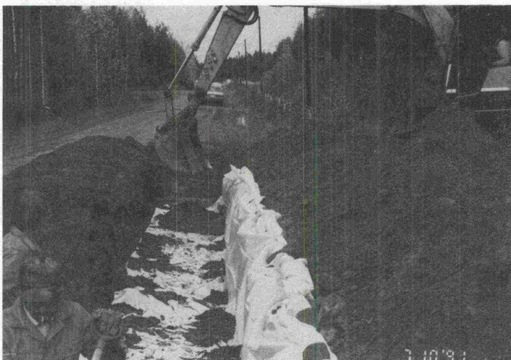
Kuva 9: Geovahvistetta asennetaan tien reunaan.
