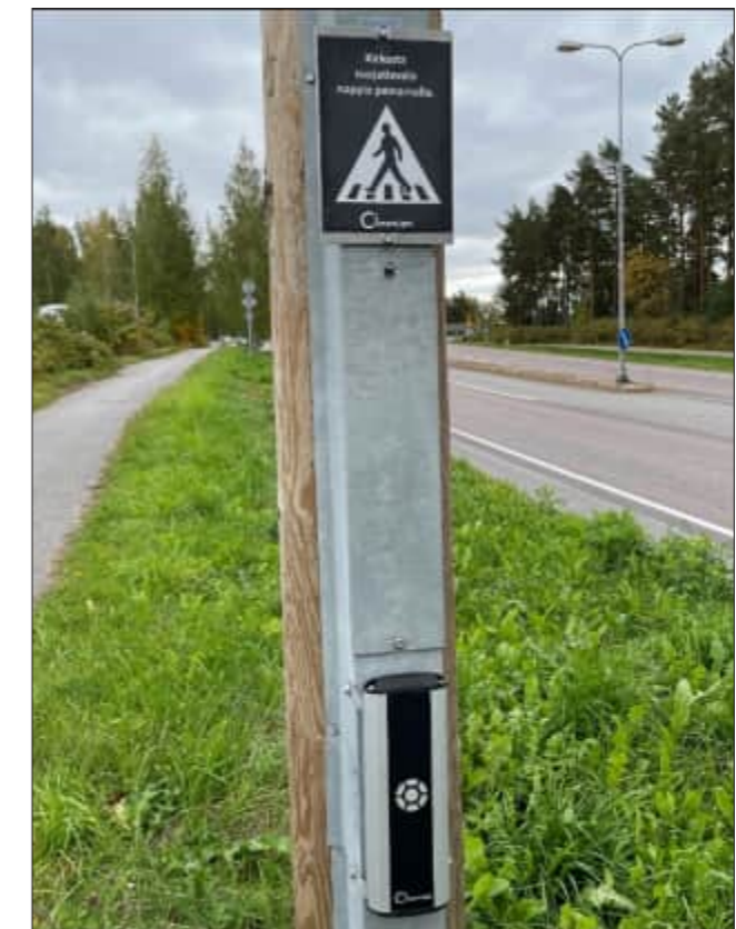
Kuva 12. Kosketuskäyttöinen säädin valtatie ylittävän suojatien lisävalaistuksen sytyttämiseen.
