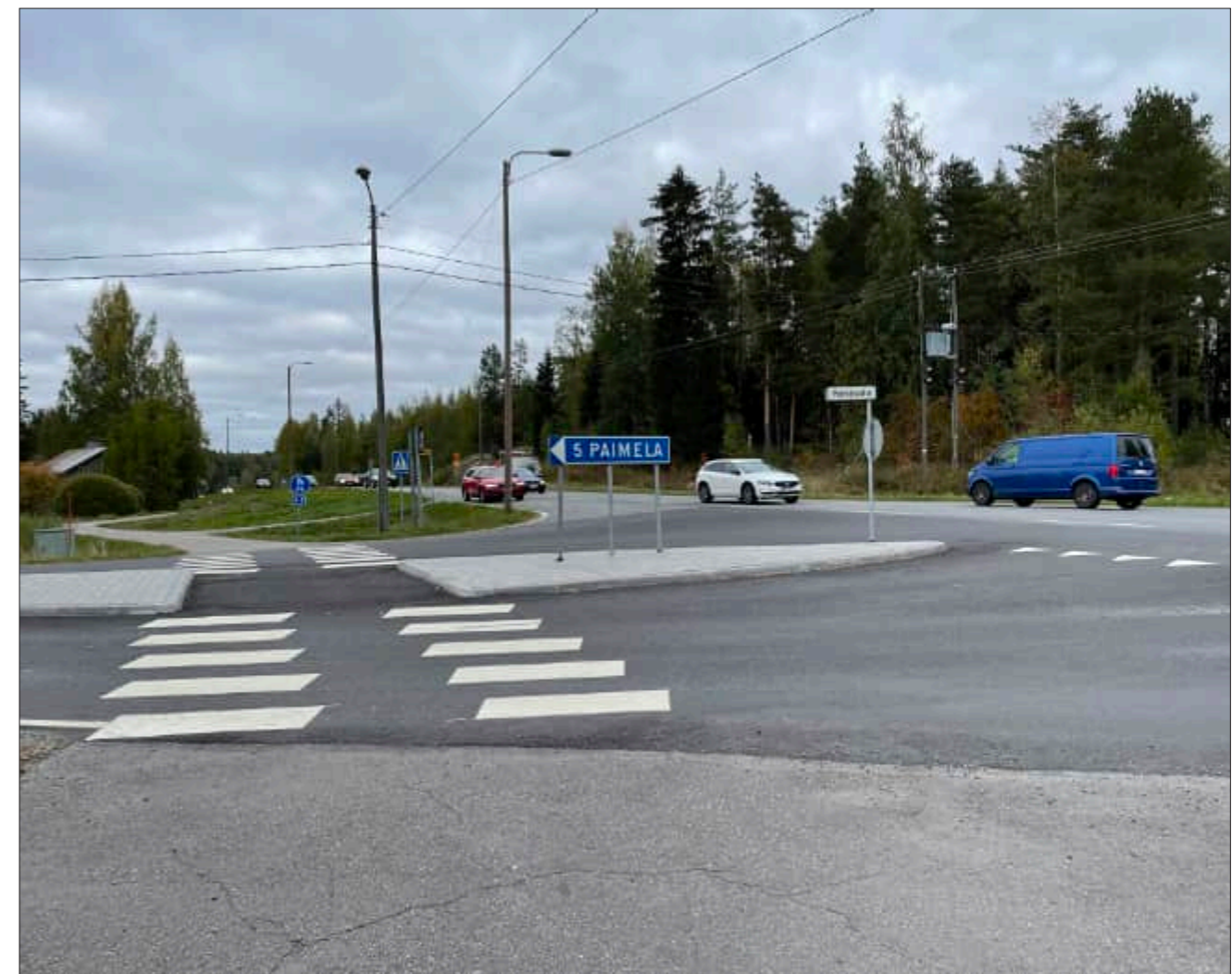
Kuva 3. Paimelantien eteläisessä liittymässä liikennemäärät ovat varsin korkeat.
