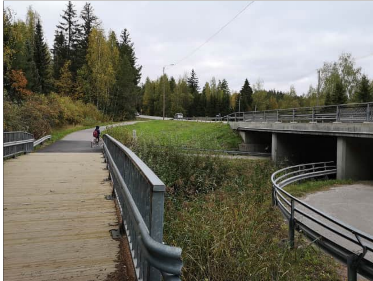
Kuva 30. Pitkäsillantien liittymän eteläpuolelta kuvattu näkymä, josta voi havainnollistaa myös läheisen kolmiaukkoisen Meijeriojan sillan.
