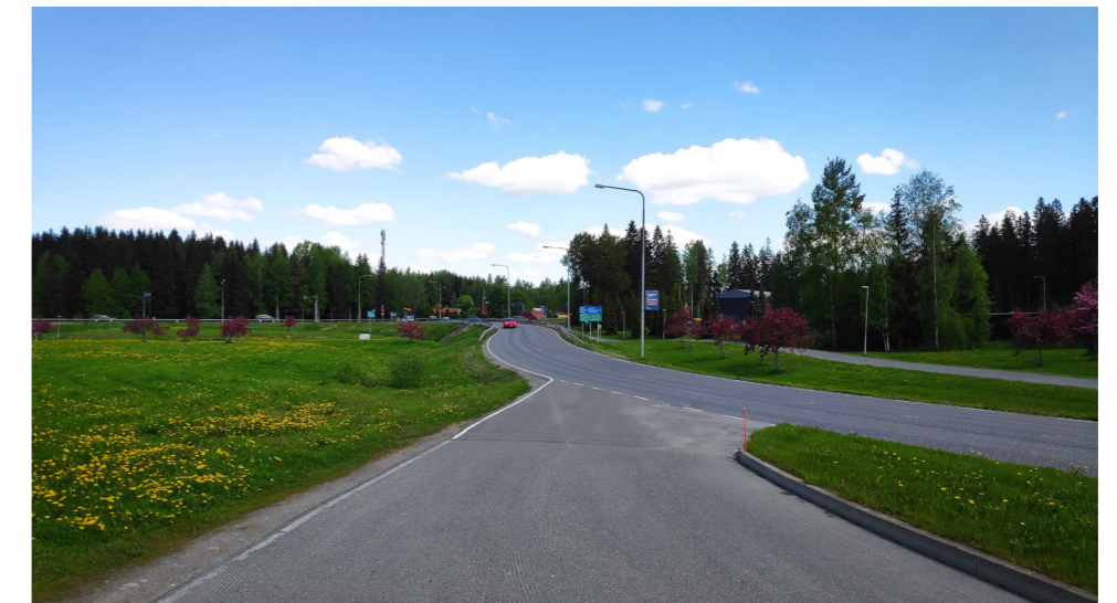
Kuva 4-5. Nykyinen Kirjauksentie hyödynnetään uuden eritasoliittymän ramppina.
