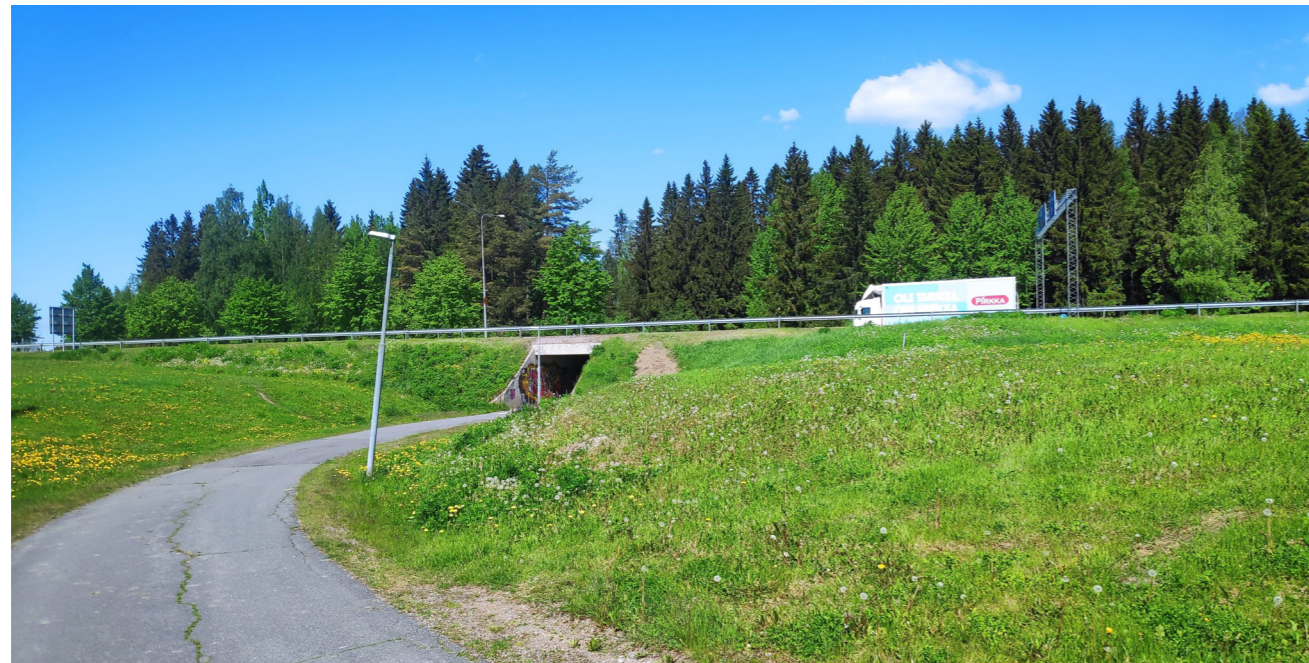
Kuva 4-6. Nykyinen Kirjauksen alikulkukäytävä kantatiellä 54 puretaan, ja jalankulku ja pyöräily ohjataan kantatien aliuuden sillan kautta.
