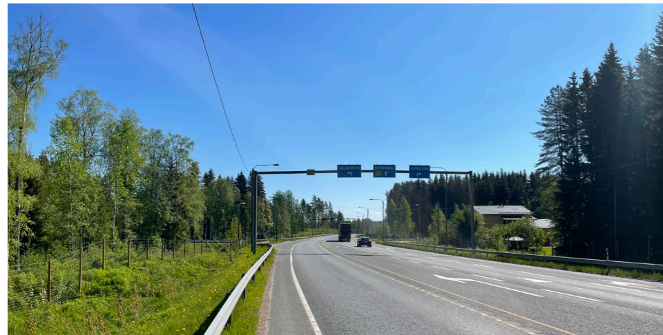
Kuva 3-1. Kormun liittymä on maanteiden nelihaaraliittymä
