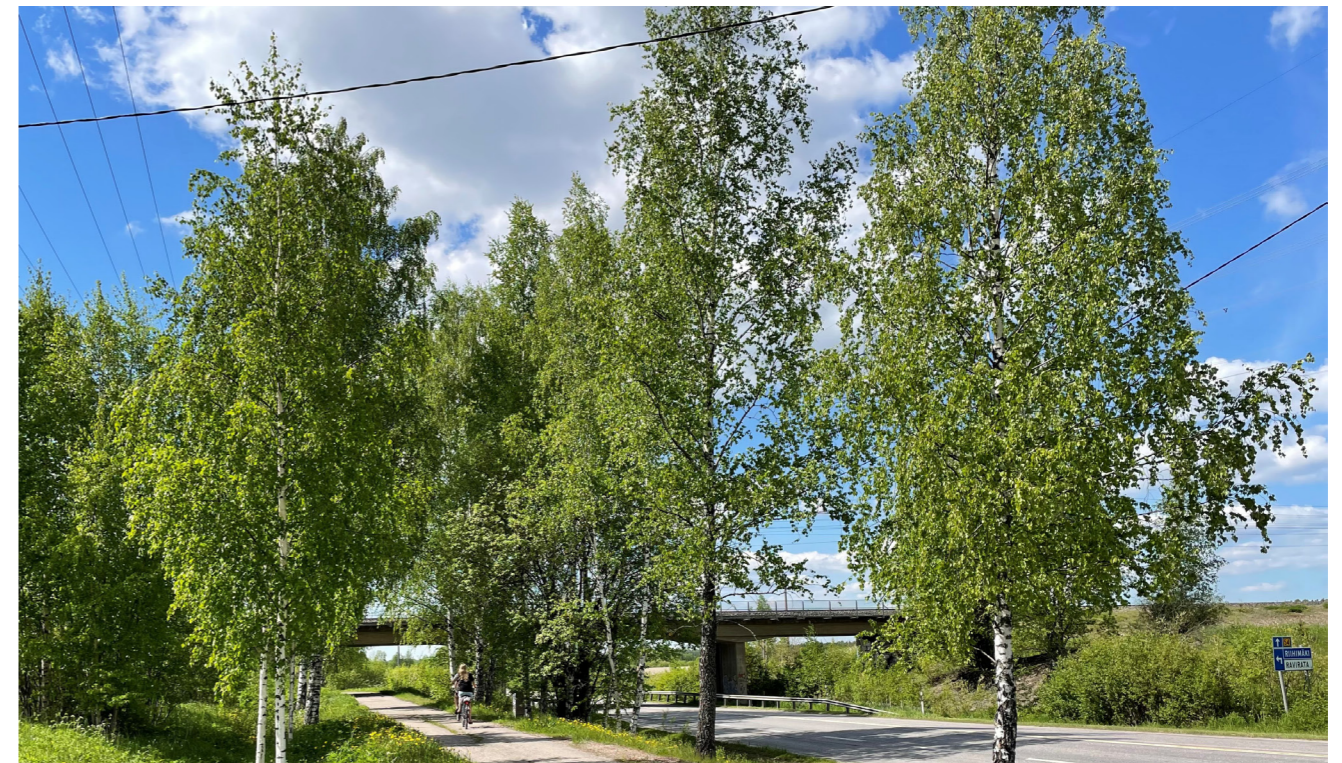
Kuva 2-9. Pohjoisen Rautateinkadun ja Karantien liittymien välillä kantatien varressa on jalankulku- ja pyöräilyväylä. Kuvassa myös pääradan silta.
