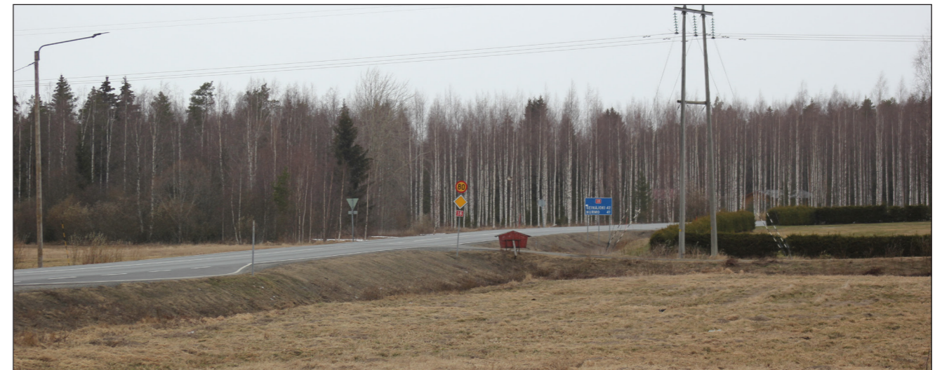
Kuva 18. Näkymä Veneskosken liittymästä pohjoiseen.
