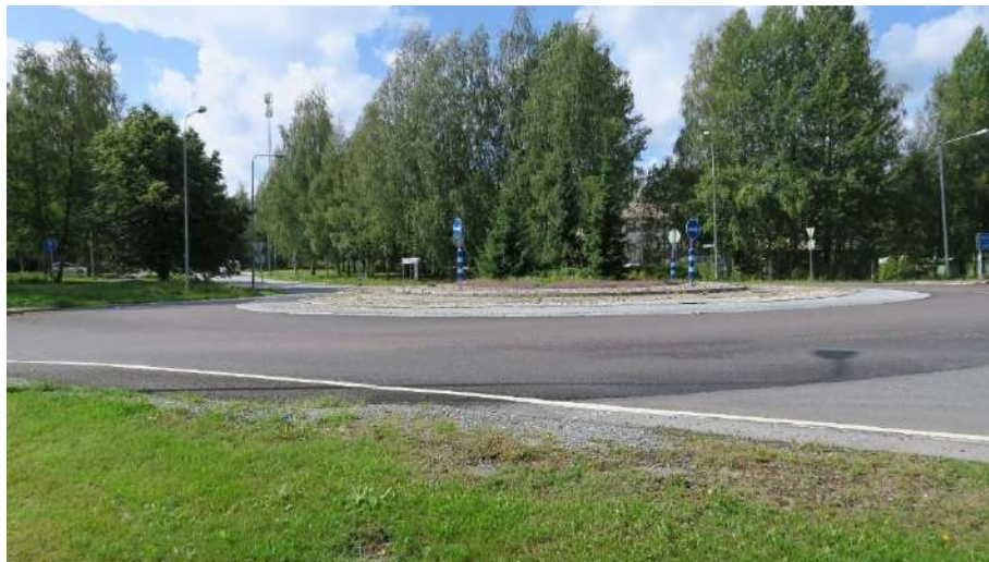
Kuva 12. Sisäänajo rautatieasemalle Pääskymäentien liikenneympyrästä. Taustalla näkyy matkustajakoti Gasthaus.
