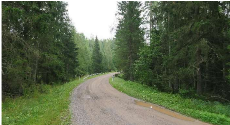
Kuva 20. Ylä-Partalantie koilliseen ennen Isosuota (Vähä-Matonen). Mutkassa kivipylväiset kaiteet ja siltarumpu luonnonkivineen.
