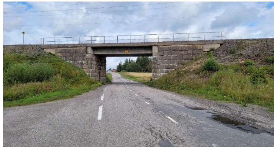
Kuva 18. Näkymä Partalantien rautatiesillan kohdalla pohjoiseen.
