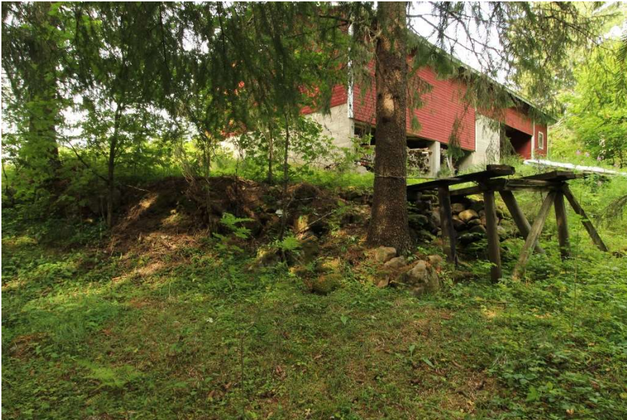
AKDG6935:12. Jämsä Kaukiala Keskinen. Muurirakennelmaa. Kuvattu idästä. Kuvaaja Heli Lehto.
