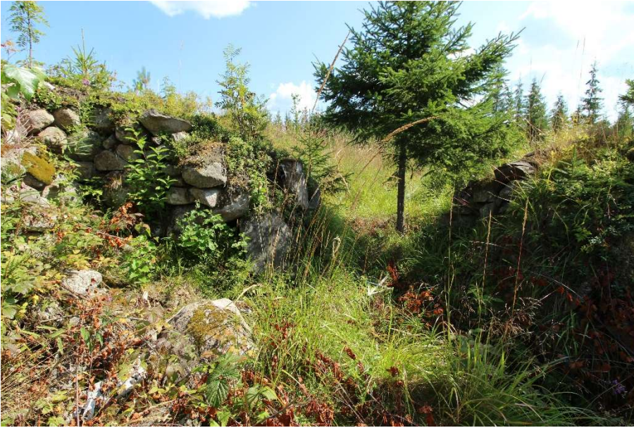
AKDG6935:45. Jämsä Kaukiala Mörkölä. Kivikellarin kaakkoisseinä ja ovi- aukko. Kuvattu luoteesta. Kuvaaja Heli Lehto.
