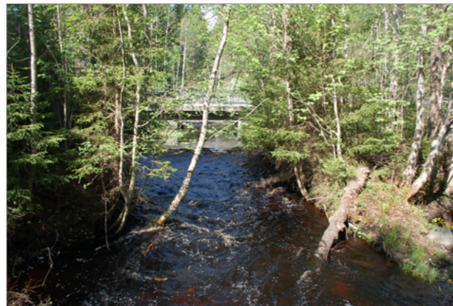
Kuva 52. Valtatie 5 ylittää Myllyjoen Vehmaan eritasoliittymän tuntumassa.
