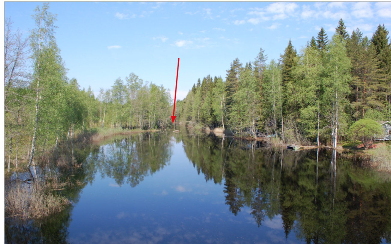
Kuva 65. Kilpolankoski nykyiseltä valtatie 5 sillalta uuden rakennettavan sillan suuntaan katsoen. Uusi silta sijoittuu kuvassa punaisella nuolella osoitetun kapeikon kohdalle.
