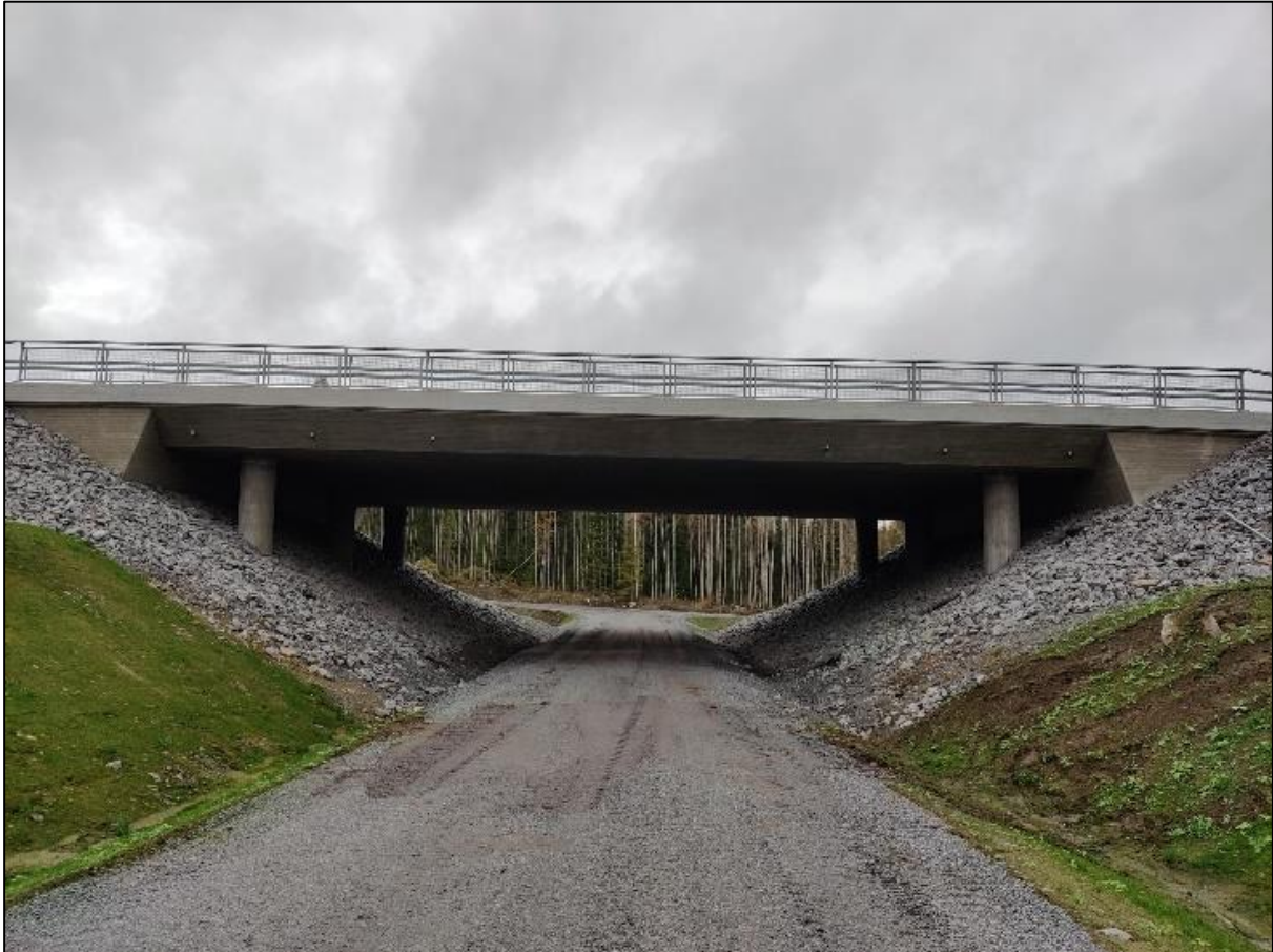
Kuva 15. V-1513 Aittamäen riistasilta (Lähde: Taitorakenne-rekisteri, https://extranet.vayla.fi/trex/#/rakenne/47785/kuva/887718 )
