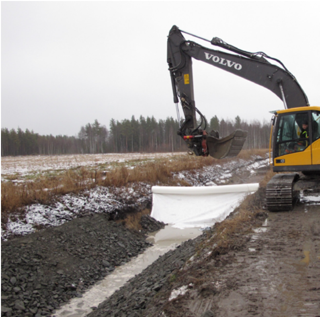
Filterduk under bergkross (kornfraktion 0–200 mm). Bild: Outi Leppiniemi
