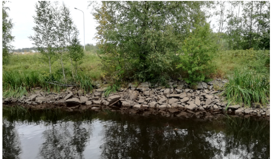
Ett gammalt strandskred har reparerats med sprängsten.
