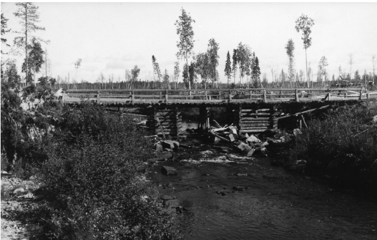
Kuva 9. Neuvostoliittolaiset pioneerit rakensivat Kattilakosken sillan hirrestä syyskuussa 1944 edettyään Raatteentietä miehittämään Suomussalmea. Suomalaiset puolestaan uusivat tämän sillan keväällä 1945. Sotaa edeltäneen sillan kivirakenteiden jäänteet näkyvät Purasjoessa. (J. E. Roimu / Väylävirasto / Mobilia).
