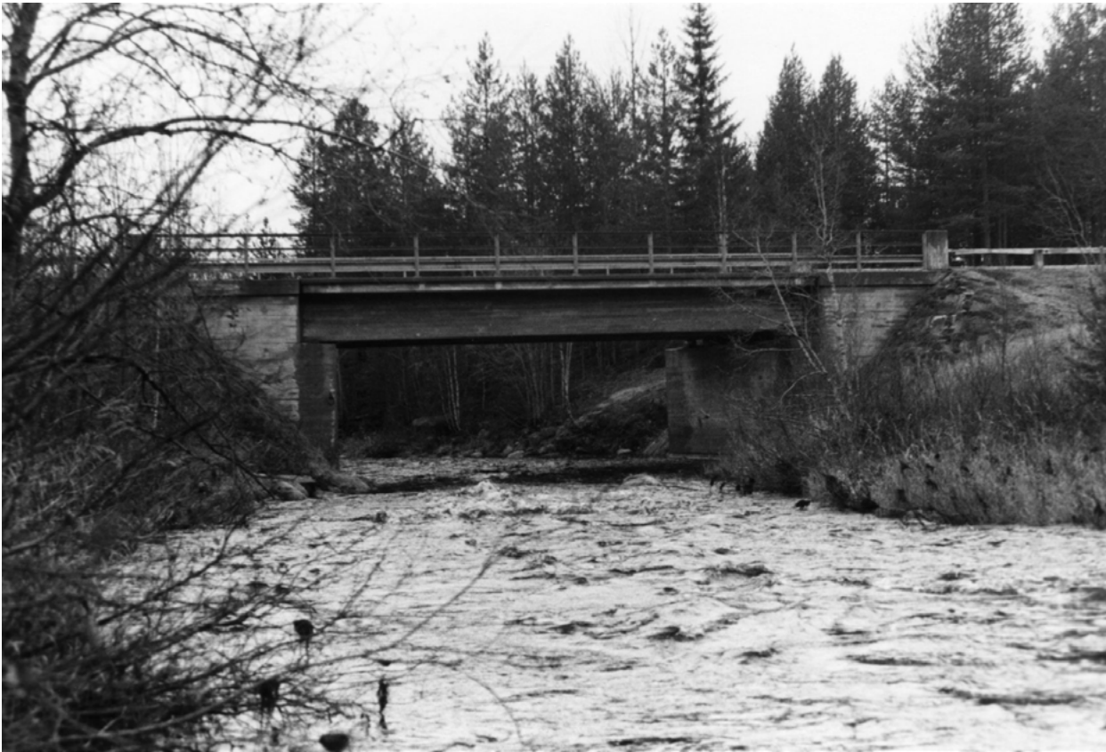
Kuva 10. 1966 valmistunut Kattilakosken nykyinen maantiesilta on tyypillinen teräsbetonista rakennettu palkkisilta. (Väylävirasto / Mobilia).
