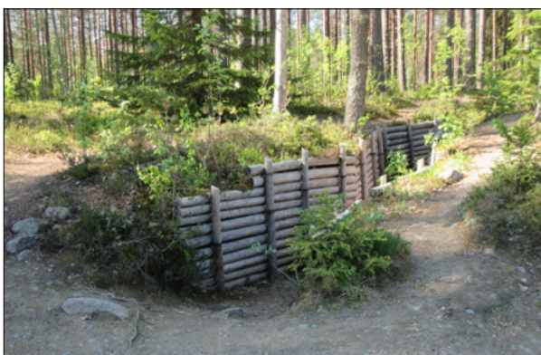
Kuva 14. Pudasjoen puolustusaseman rakenteita.
