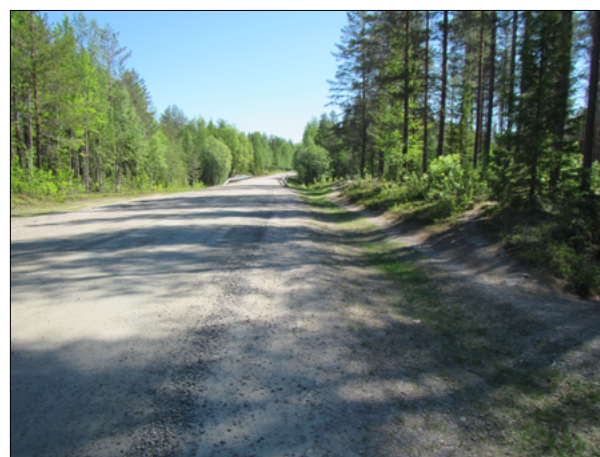
Kuva 30. Tien reunoja käytetään pysäköintipaikkoina Purasjoen kohdalla erillisestä pysäköintialueesta huolimatta. Tien vasemmalla reunalla näkyy alkuperäisen tielinjan liittyminen nykyiseen tiehen.
