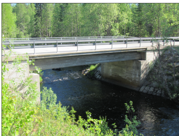
Kuva 29. Purasjoen ylittävä Kattilakosken silta, joka on teräs-betoninen palkkisilta.
