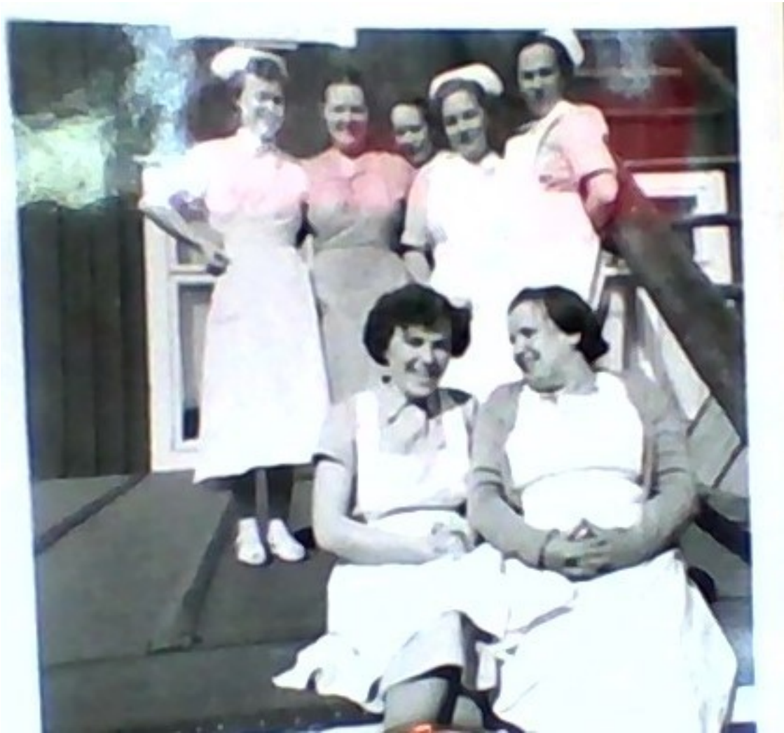
Några ur personalen samlade på taket till pannrummet i anslutning till Övermark sjukhus. Fotografen okänd.
