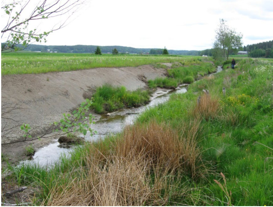
Kuva 19. Juottimenojan kaksitasouoma kaksi vuotta rakentamisen jälkeen. Lähde: Västilä 2021
