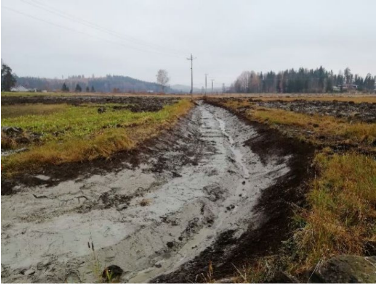
Kuva 13. Piilonojan haaraojan kaksitasouoma rakentamisen jälkeen syksyllä 2018. Lähde: Ketola ym. 2019: 14
