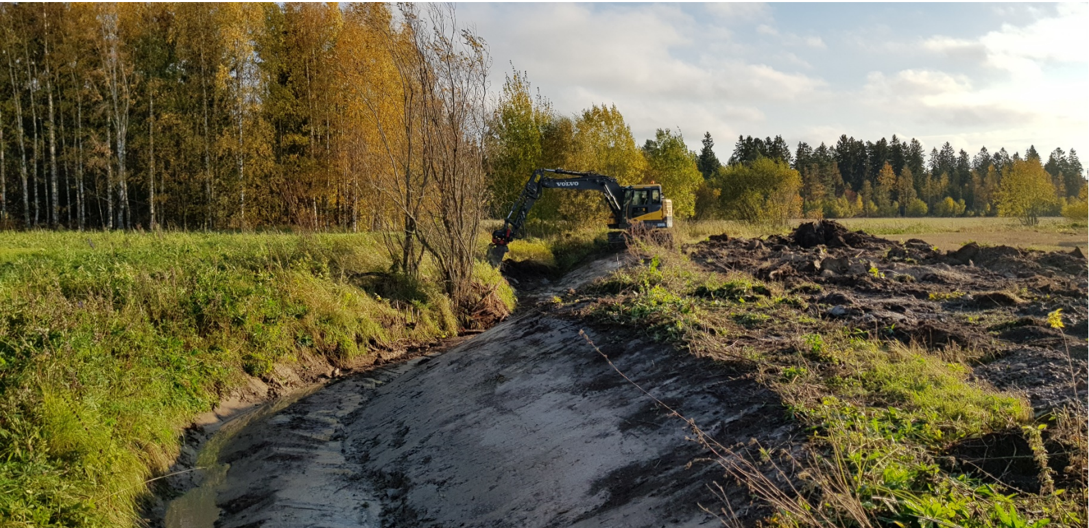
Kuva 22. Säskylän Luvalahteen kaivettiin kaksitasouomaa syksyllä 2020. Kuva: Pyhäjärvi-instituutti
