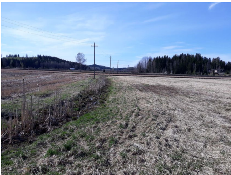
Kuva 12. Piilonojan sivuhaaraoja oli tukossa kasvimassasta ja lietteestä ennen kaksitasouoman rakentamista. Lähde: Ortamala 2018: 9
