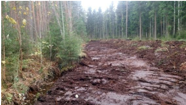
Kuva 15. Pipakallionsuon valmis tulvatasanne kaivun jälkeen lokakuussa 2016. Lähde: Joensuu ym. 2017: 19
