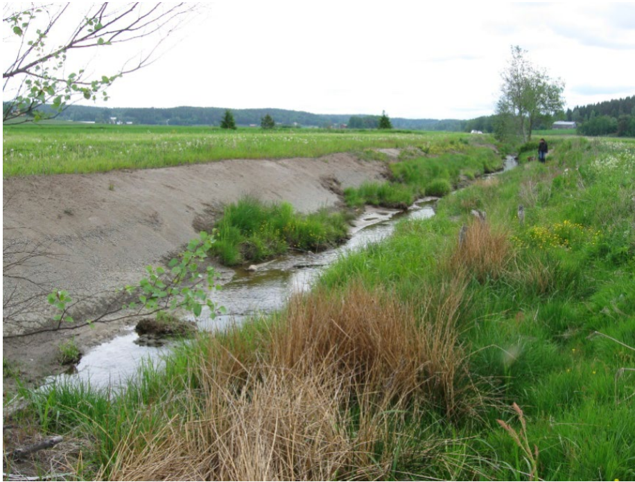
Bild 19. Tvåstegsdiket längs Juottimenoja två år efter att det anlagts. Källa: Västilä 2021
