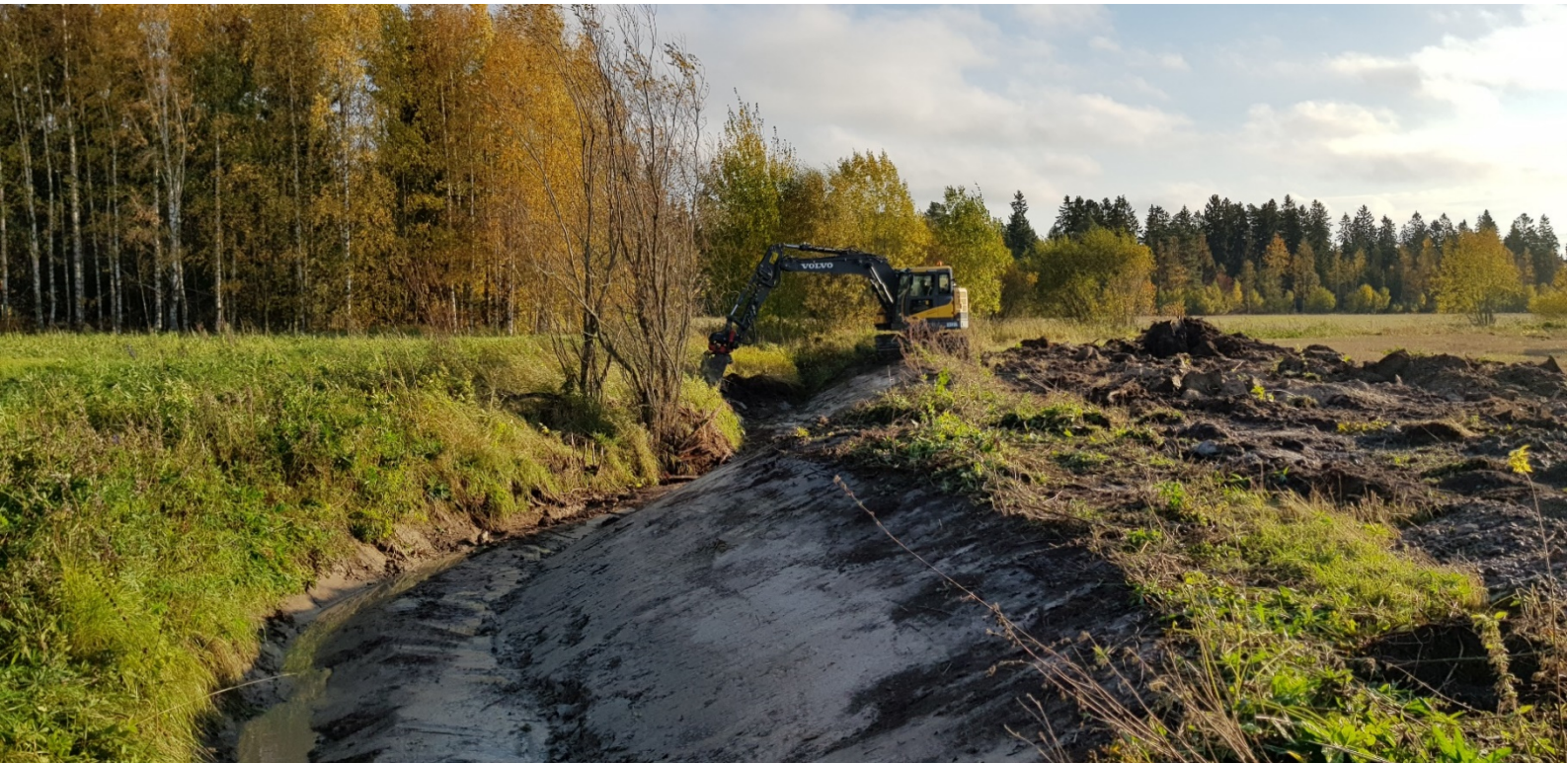
Bild 22. I Luvalhti i Säkylä grävdes ett tvåstegsdike hösten 2020. Bild: Pyhäjärvi-instituutti
