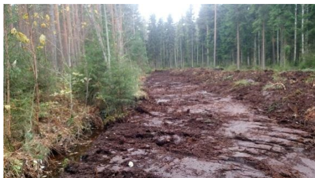
Bild 16. Pipakallionsuos färdiggrävda översvämningsyta i oktober 2016. Källa: Joensuu m.fl. 2017: 19
