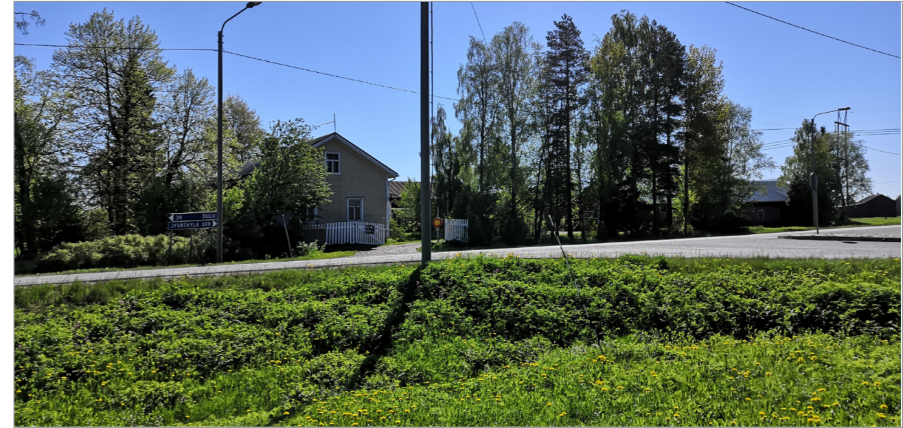
Kuva 28. Tarvittavan meluntorjunnan toteuttaminen valtakunnallisesti arvokkaalla maisema-alueella ja RKY-alueella, jossa rakennukset sijaitsevat lähellä tietä, on haasteellista.
