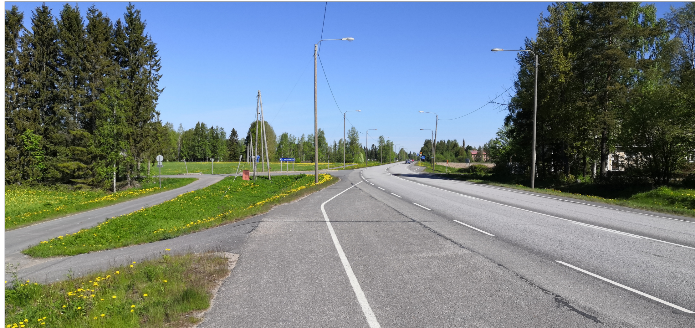
Kuva 16. Valtatie 4 pienisäteiset kaarteet edellyttävät linjausmuutoksia yhteensä noin 5,4 kilometrin osuudelle. Kuvassa näkyvän Vehkamaantien (mt 18632) liittymän etelä- ja pohjoispuolella valtatie tulee siirtää uudelle tielinjalle yhteensä noin 1,5 km osuudella, jotta saavutetaan tavoiteltu keskikaidetien tiegeometria. Liittymässä tien itäpuolella (kuvassa tien oikealla puolella) sijaitseva RKY-kohde Ollila ei mahdollista valtatie siirtämistä itään päin.
