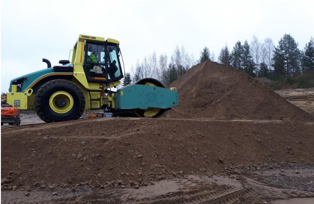
Kuva 6.12: Penkereen I tiivistys 23 t valssijyrällä
