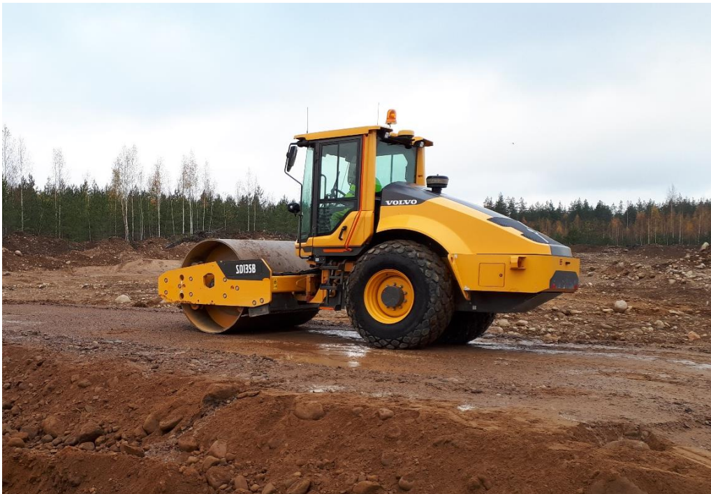
Kuva 6.6: Koepenkereiden tiivistämiseen käytetty 13 t valssijyrä
