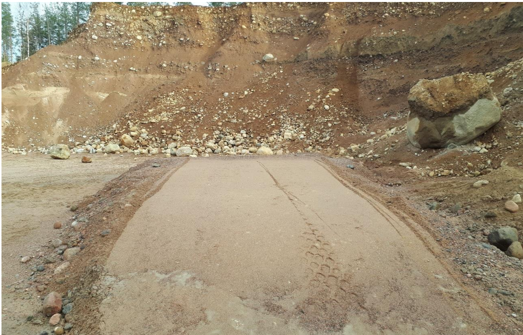
Kuva 6.8: Koepenkeren A ensimmäinen kerros
