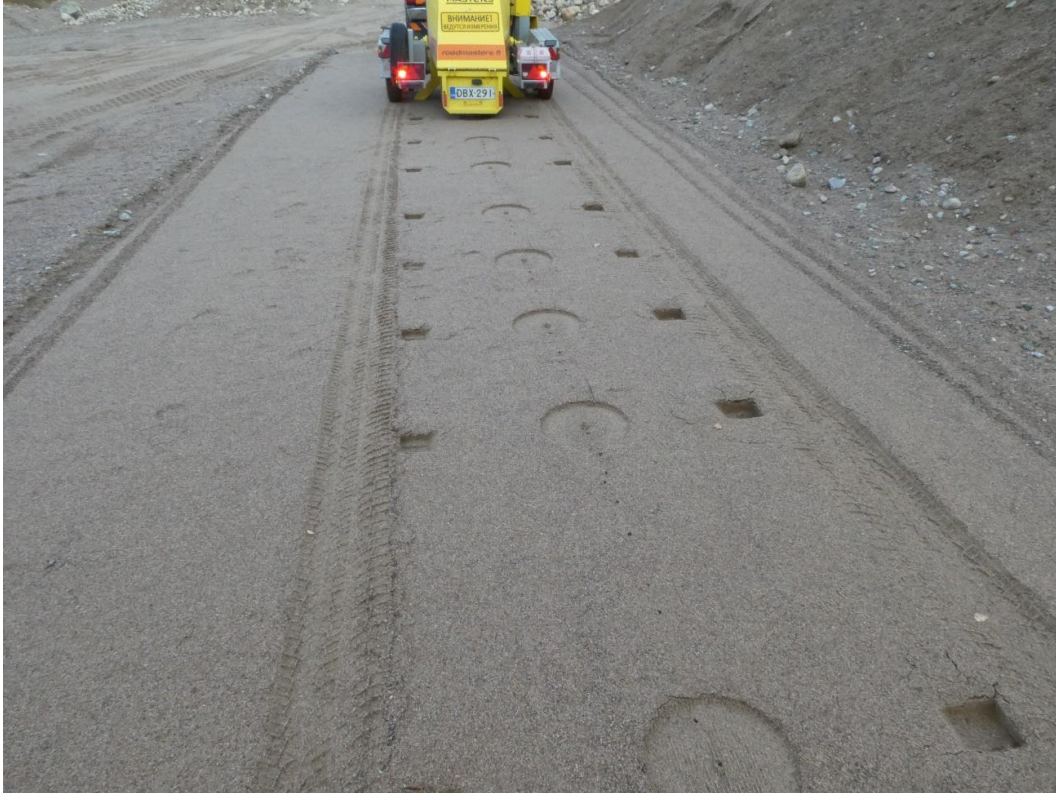
Kuva 6.13: PPL-mittaukset penkereelle E
