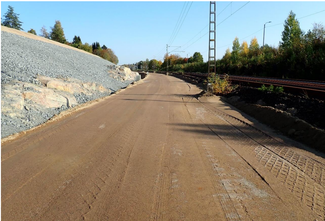
Kuva 6.1: Mittauspäivänä tiivistetty eristyskerros
