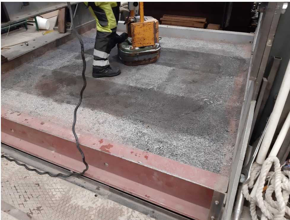
Kuva 6.20: Koerakenteen alusta ja tiivistämiseen käytetty tärylevy
