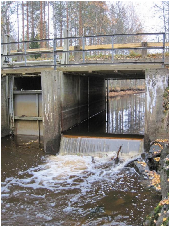
Kuva 4. Lokakuussa 2018 vedenpintaa laskettiin Kuotesjärven luusuassa olevan settipadon yli säännöstelyluukun ollessa kiinni.
