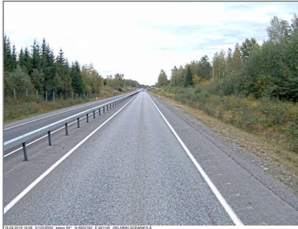
Kuva 26. Esimerkki 1+1-kaistaisesta keskikaiteellisesta valtatiestä (valtatie 5 Mäntyharjulla). Lähde: Tiekuva.
