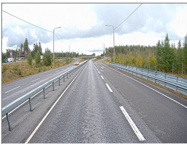
Kuva 28. Esimerkki 2+1-kaistaisesta keskikaiteellisesta valtatiestä rombin eritasoliittymän kohdalta (valtatie 5 Mäntyharju). Lähde: Tiekuva
