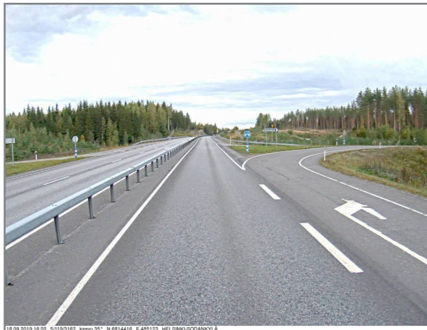
Kuva 27. Esimerkki 2+1-kaistaisesta keskikaiteellisesta valtatiestä yksityistien eritasoliittymän kohdalta (valtatie 5 Mäntyharjulla). Lähde: Tiekuva
