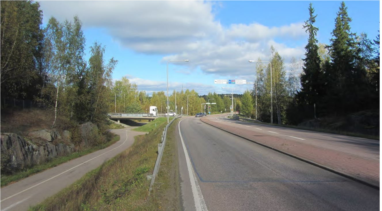
Kuva 64. Näkymä Merituulentieltä Kotkansaaren suuntaan Mussalontien nykyiseen liittymään. Vasemmalla toinen purettavista Etukylän alikulkukäytävistä.
