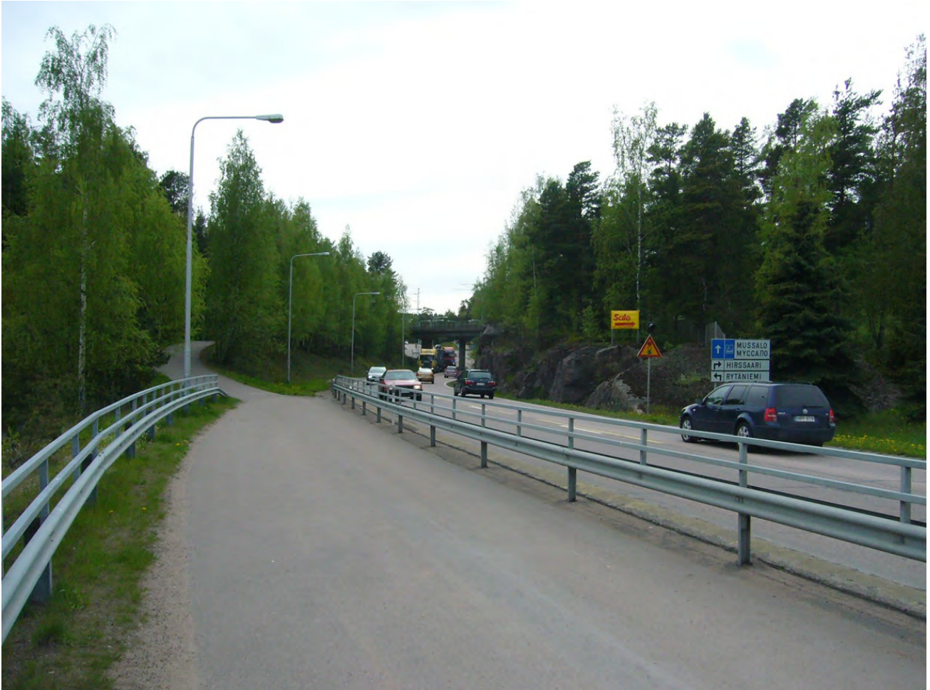
Kuva 8. Esimerkki nykyisen tien soveltumattomuudesta raskaalle liikenteelle Hirssaarentien liittymän läheisyydessä Mussalon radan ylittäessä tien.
