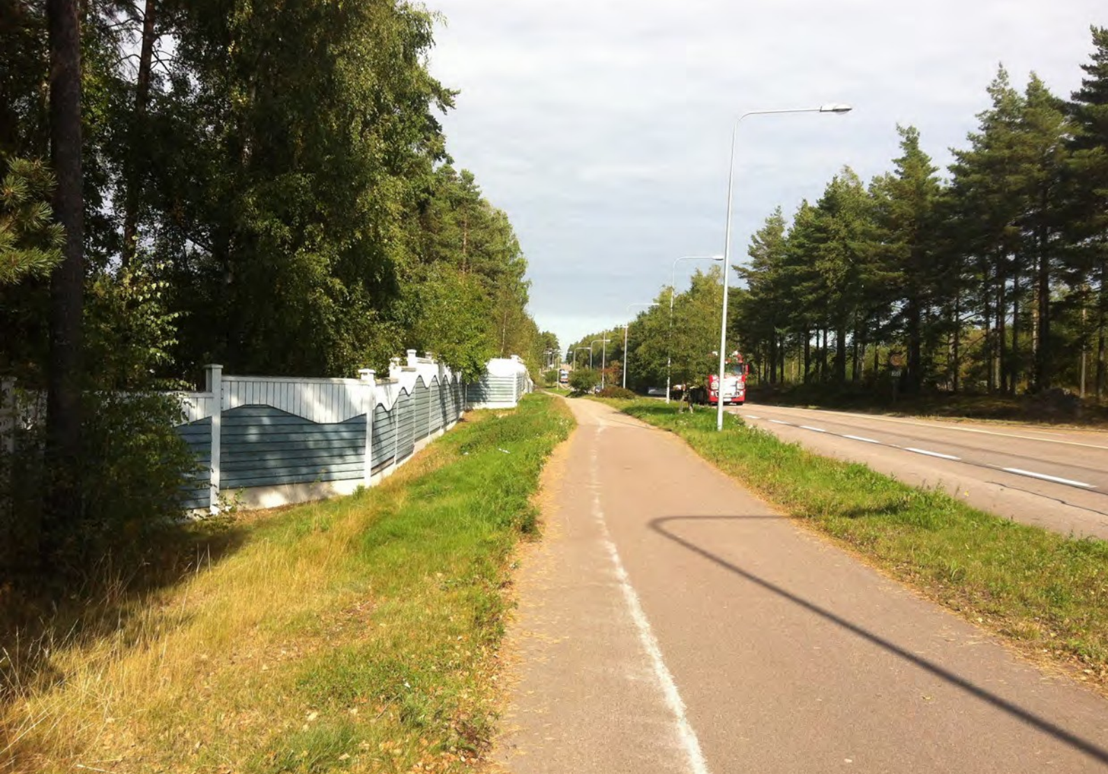
Kuva 45. Takakylän asuinalueen puolelle on rakennettu meluaita ja sataman puolelle kuusien takana näkyvä meluvalli.
