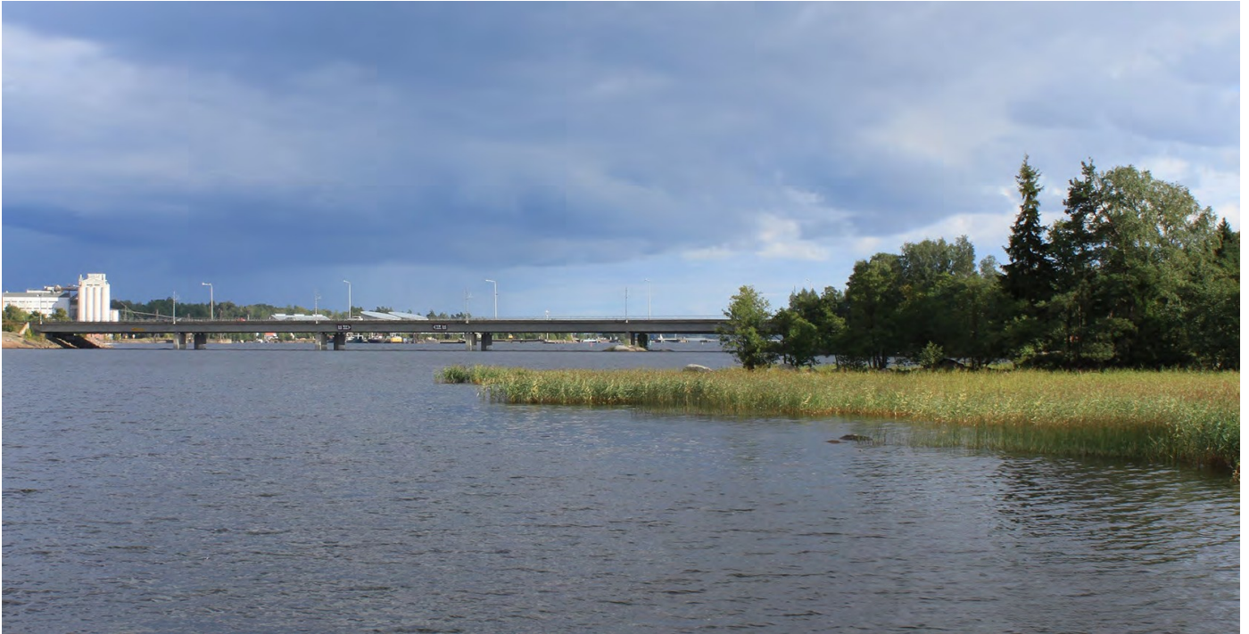
Kuva 65. Nykyiset Norssalmen sillat (maantie- ja ratasilta) pohjoisesta katsottuna.
